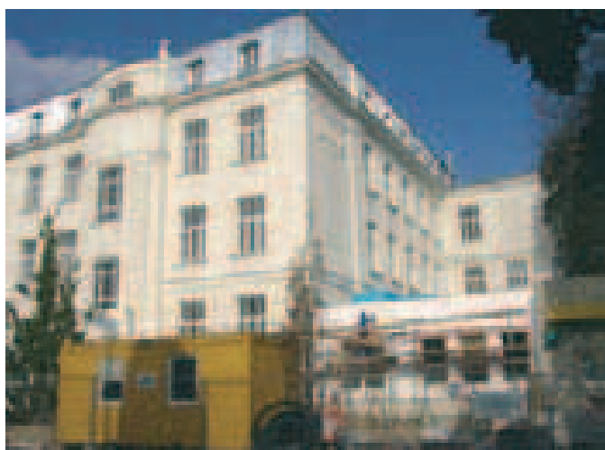
Sanierung des Cieslar-Hauses. Wärmeisolierungen sparen Heizenergie
