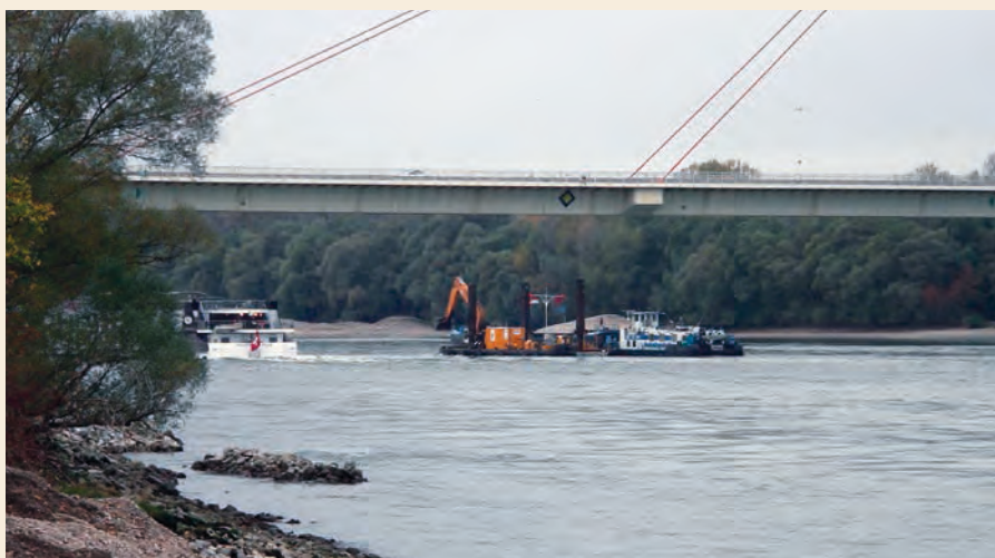
Flusskreuzfahrt passiert Baggerponton unter Hainburger Donaubrücke
