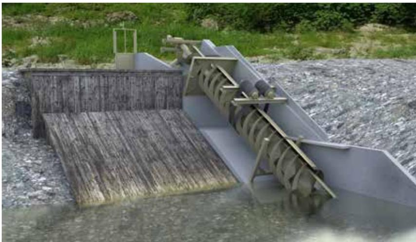
Fischeaufstiegshilfe von „Hydroconnect“. Visualisierung, Schneckeneinblick
