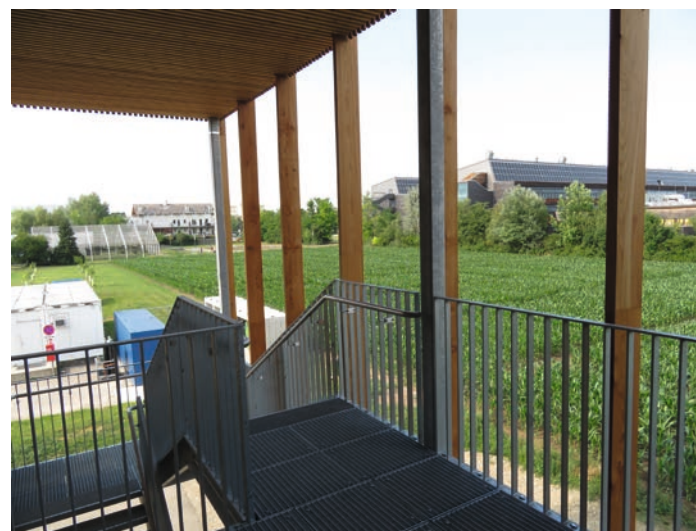
Eine kleine Terrasse mit Blick auf die Kukuruz-Äcker ist aus Sicherheitsgründen mit einer Stahltreppe versehen.
