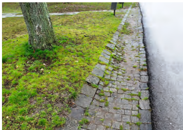
Offener Entwässerungsgraben – was in den Niederlanden aktuell als innovative Maßnahme zur Klimaanpassung vorgeschlagen wird (Atelier Groenblauw, 2018), hat in Niš eine lange Tradition.
