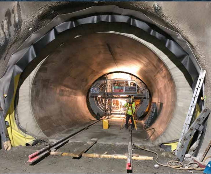
Herstellung der Innenschale im Querschlag
