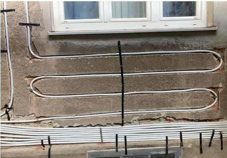
Abbildung 2: Detailansicht der befestigten Kunststoffrohre in der Wand, die nachfolgend mit Mörtel verputzt und mit einem Wärmedämmverbundsystem überdeckt werden
