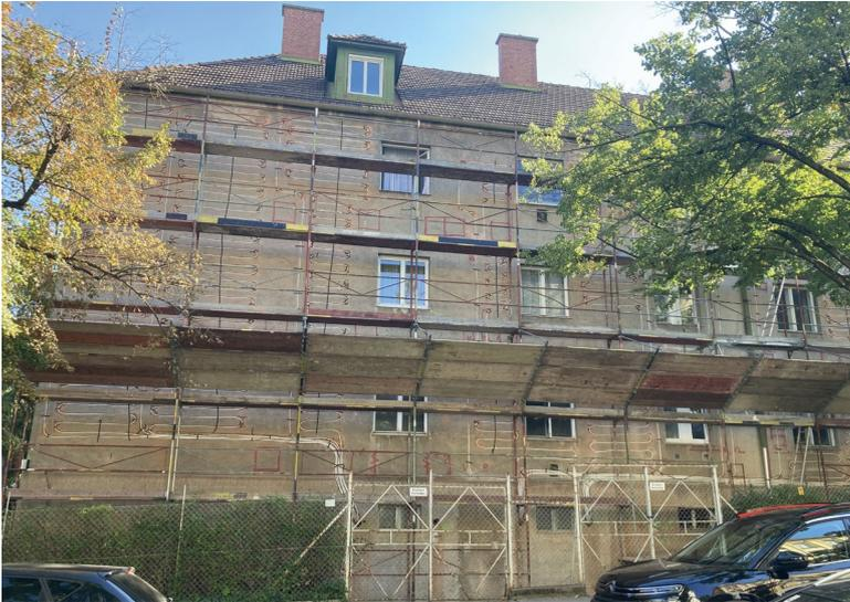
Abbildung 1: Anbringung der Heizungsrohre in der Fassade in der Eichendorffgasse
