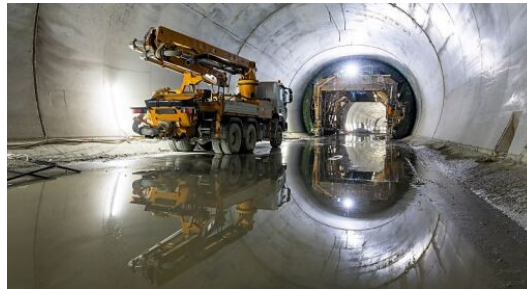
© BBE-SE Der Brenner Basistunnel ist in der Entstehung..
