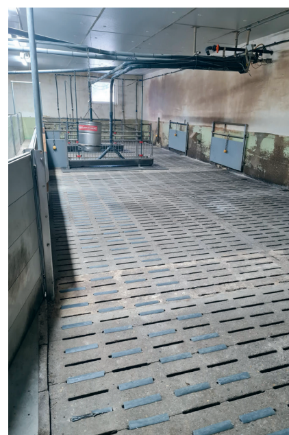
Ein Teil der Spalten ist mit Clips geschlossen.
