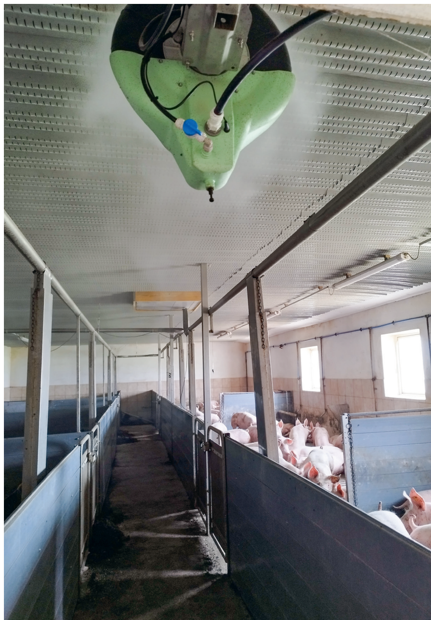
Hochdruckvernebelung zur Kühlung in der Schweinemast.
