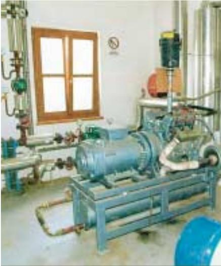
Im Blockheizkraftwerk wird Methan zu Strom und Wärme umgewandelt. Fotos: Institut für Land-, Umwelt- und Energietechnik der BOKU, Fiedler
