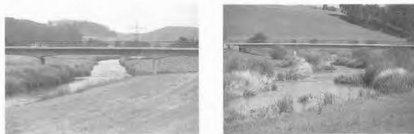
**Abb. 7.20** Melkfluss: Monoton regulierte Strecke (links) und restrukturierter Abschnitt (rechts); Fotos: Abt. f. Hydrobiologie.
