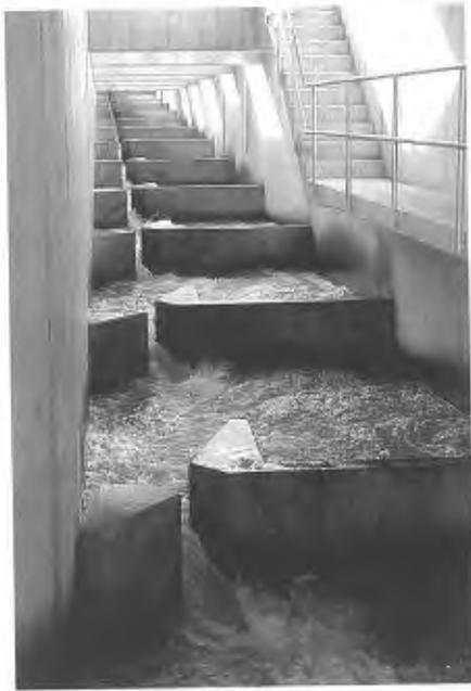
Abb. 10.32 Beckenkaskade mit typischem Strömungsbild (aus Heimerl et al. 2002).
