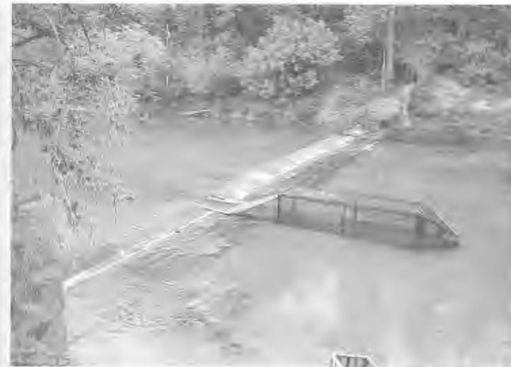
**Abb. 10.43** Das so genannte „resistance board weir“ (Tobin 1994) an der Pielachmündung, wie es in Kanada und den USA vor allem für die quantitative Erfassung der Lachswanderung eingesetzt wird. Während des dreijährigen Monitorings werden hier sämtliche aus der Donau im Frühjahr einwandernde Fische registriert und markiert; Foto: Abt. f. Hydrobiologie.
