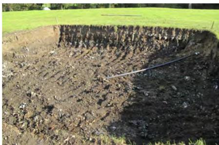
*Die Fensterfläche wird abgegraben und die bestehende Gasleitung mittig zugeführt.*
