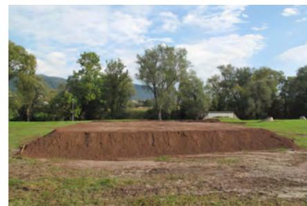
*Um einen unerwünschten Deponiegasaustritt im Randbereich der Fenster zu verhindern bzw. die oxidationsaktive Filterfläche zu vergrößern, wird das reife Kompostmaterial mit einem Überhang aufgebracht.*
