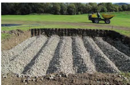
*Für eine optimale Gasverteilung bei Stauwasser wird bei einigen Fenstern die Gasverteilungsschicht versuchsweise in ZickZack-Form ausgeführt.*
