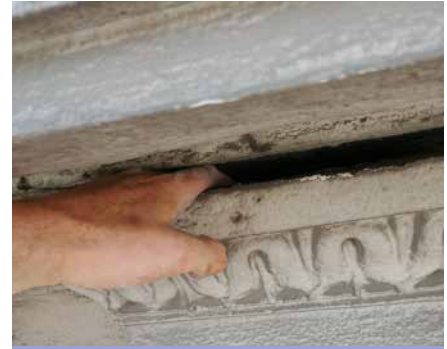
Als Brutplatz geeignetes Stuckelement
