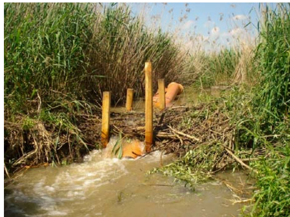
Abb. 4.11. Dammdrainage im Bereich einer Bachaufweitung, hier wurde der Damm vor dem Einbau des Rohrs mit einem Bagger geöffnet (li.o.). Es wurden geschlitzte Rohre in Kombination mit längeren Stehern verwendet. Lange Steher sind schwerer zu transportieren und i.d.R. nur aus Fichtenholz erhältlich. Längere Pflöcke bedingen auch eine höhere Position beim Einschlagen der Steher, dazu ist unter Umständen eine Stehleiter notwendig. Das Bild rechts unten zeigt ein mit 4 Fichtenholzpflöcken fixiertes Drainagerohr mit einem 30° Kniestück an der Einstromöffnung. ©G.Hölzler
