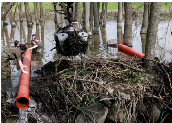
Abb. 4.10. Eine bis heute funktionierende Lösung sind 2 Rohre mit rundum geschlossenen Gitterkörben (li), genauso wie ein glattes Rohr mit 50cm Durchmesser (re). Statt einem Gitterkorb wurde hier ein geschlitztes Blechfass mit einer quer durchgesteckten Eisenstange zur Befestigung am Rohreinlauf angebracht. ©G.Hölzler
