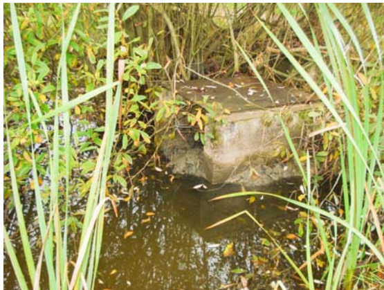
Abb.5.2. An einem Teich wurde der Mönch verstopft (li), das Durchflussbauwerk eines Hochwasserschutzdammes wurde durch Astmaterial blockiert (re). ©G.Hölzler
