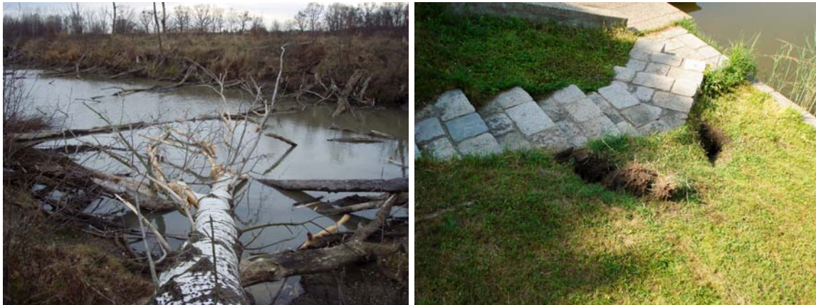
Abb.7.1. Ein Fischteich mit gefälltten Uferbäumen und völlig unterwühlten Ufern (li) ©R.Parz-Gollner, Röhreneinbrüche an der Uferböschung eines Badeteiches (re), ©G.Hölzler
