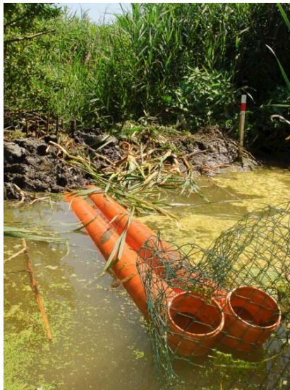
Abb. 4.13. Horizontal eingebaute Rohre sind leichter zu positionieren und zu fixieren, der Gitterkorb zum Schutz der Einströmöffnung sollte auf keinen Fall fehlen. ©G.Hözlner
