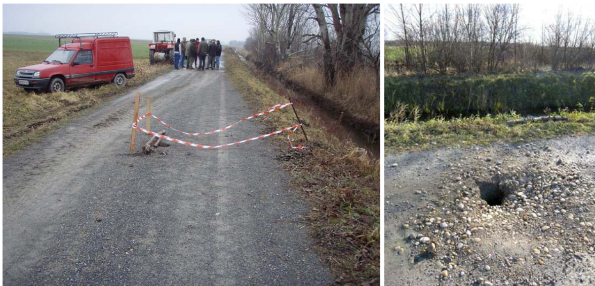
Abb.6.6. Röhreneinbrüche, die unter Wirtschaftswegen liegen, müssen rasch saniert werden. Werden Einbrüche entdeckt, dann sollten diese mit Pflöcken oder großen Ästen markiert und sichtbar gemacht werden, damit es zu keinen Unfällen kommt. ©R.Parz-Gollner
