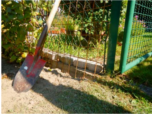
Abb.7.7. Zusätzliche Auflagen von Gitterstreifen werden als Zaunverbesserungen montiert, um den Biber von Gartengrundstücken auszusperrten. ©G.Hölzler
