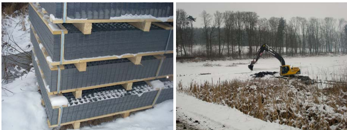
Abb.7.9. Verzinkte Estrichgitter zur Dammsicherung (li), die Arbeiten wurden mittels Einsatz von Großmaschinen durchgeführt (re). ©G.Hölzler
