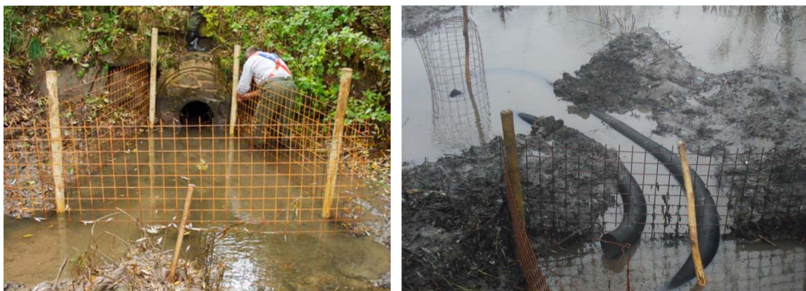
Abb.5.6. Der trapezförmige Gitterkorb zur Sicherung des Rohrdurchlasses wurde aus 1cm starken Baustahlgitter gefertigt (li). In einer nachträglichen Erweiterung zur Absicherung der Wasserabfuhr wurden an dem Frontgitter eines Korbes noch zwei Drainageschläuche mit einem abschließenden Gitterkorb montiert (re). ©G.Hölzler
