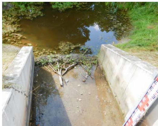
Abb.5.3. An einem Straßendurchlass wurde zum Schutz der Rohre ein senkrechte Gitter montiert (li), ein Dammdurchlass wurde durch das vom Biber aufgetürmte Material verlegt (re). ©G.Hölzler
