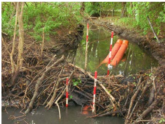
Abb. 4.12. Verschiedene Varianten von schräg in den Biberdamm eingebauten Rohren:
