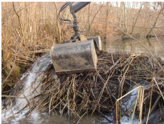
Abb.4.7. Damm-Absenkung mit maschineller Hilfe (li). Die normale Gewässerbreite beträgt rund 1,6m und die Tiefe rund 30cm. Die Aufstauung verursachte eine Tiefe von ca. 1,8m und eine Breite von ca. 5m, dadurch wurde eine bachaufwärts liegende Überflutungsmulde überschwemmt. Kontrolliert abfließendes Wasser bei einem schrittweise händisch geöffneten Damm (re). ©G.Hölzler
