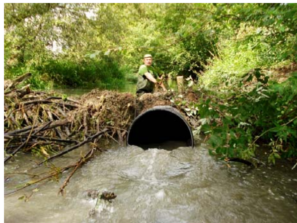
Abb. 4.9. Rohre mit großem Durchmesser (hier 80cm) können vom Biber kaum zugebaut werden und haben sich in der Praxis bewährt, einzig der hohe Preis ist ein Manko. ©G.Hölzler
