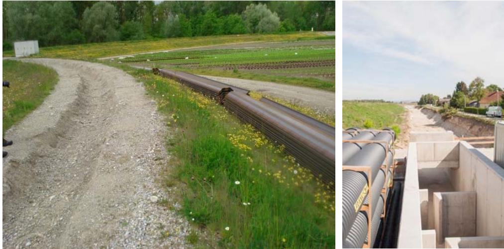
Abb.6.8. Spundbleche aus Metall liegen zum Einbau bereit (li.), Blick auf den parallel zum Stauraum eines Kraftwerks an der Enns verlaufenden Seitengraben, wo zur Umgehung der Kraftwerksbarriere eine Fischaufstiegshilfe eingebaut wurde (re). ©G.Hölzler
