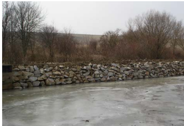
Abb.7.11. Auch komplette Uferversteinerungen wurden zum Schutz gegen Biberaktivitäten an Teichanlagen bereits umgesetzt. ©G.Hölzler
