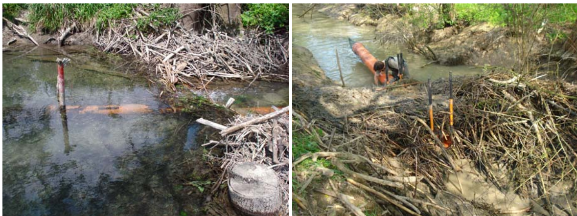
Abb.4.15. Ein in Bodennähe eingebautes, zusätzlich geschlitztes Drainagerohr (li), nach dem Einbau und der Fixierung des schräg liegenden Rohres wurde der Damm wieder verschlossen (re). ©G.Hölzler
