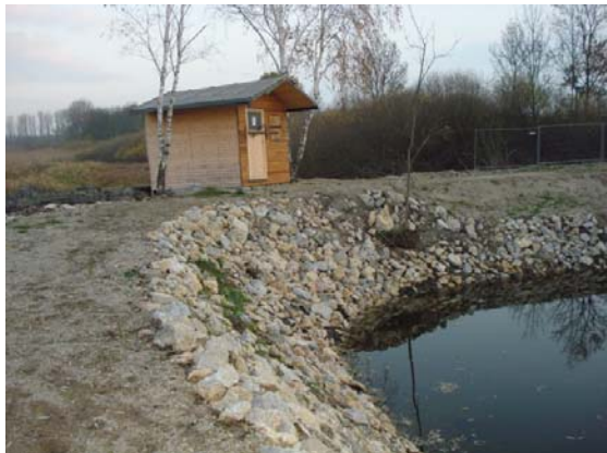
Abb.7.11. Auch komplette Uferversteinerungen wurden zum Schutz gegen Biberaktivitäten an Teichanlagen bereits umgesetzt. ©G.Hölzler
