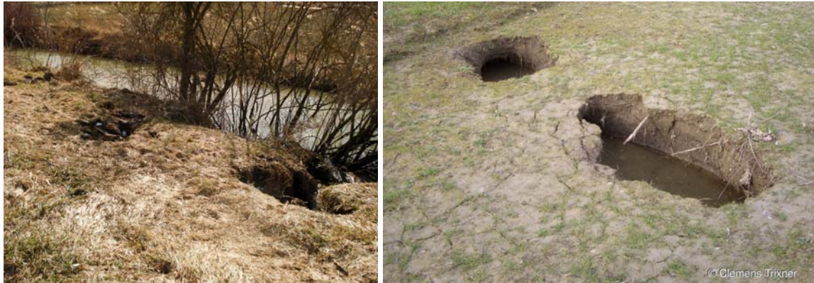
Abb. 6.1. Röhreneinbrüche entlang des Gehölzsaums am Ufer eines Gewässers (li, ©G.Hölzler) und in einem Uferdamm (re, ©C.Trixner).
