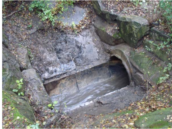
Abb.5.1. Eine Ansammlung von Material in einem Halbschalenrohr behindert den Abfluß aus einem Retentionsbecken (li), das Material wurde händisch entfernt (re). ©G.Hölzler
