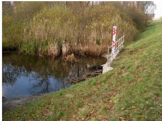
Abb.5.2. An einem Teich wurde der Mönch verstopft (li), das Durchflussbauwerk eines Hochwasserschutzdammes wurde durch Astmaterial blockiert (re). ©G.Hölzler
