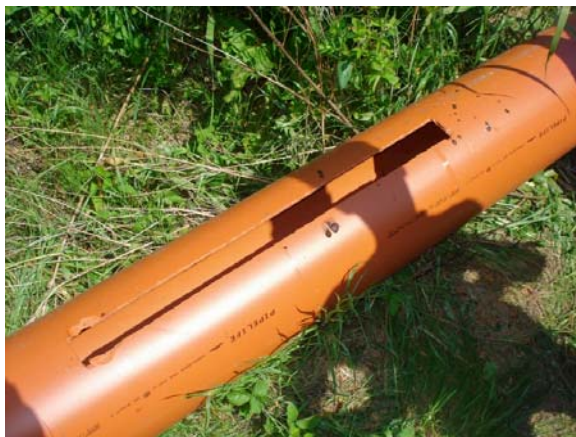
Abb. 4.11. Dammdrainage im Bereich einer Bachaufweitung, hier wurde der Damm vor dem Einbau des Rohrs mit einem Bagger geöffnet (li.o.). Es wurden geschlitzte Rohre in Kombination mit längeren Stehern verwendet. Lange Steher sind schwerer zu transportieren und i.d.R. nur aus Fichtenholz erhältlich. Längere Pflöcke bedingen auch eine höhere Position beim Einschlagen der Steher, dazu ist unter Umständen eine Stehleiter notwendig. Das Bild rechts unten zeigt ein mit 4 Fichtenholzpflöcken fixiertes Drainagerohr mit einem 30° Kniestück an der Einstromöffnung. ©G.Hölzler
