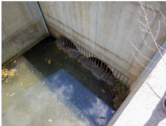
Abb.5.8. Senkrecht stehende Gitter an Auslaufbauwerken erleichtern das Abdichten einer Öffnung und sind schwer zu reinigen. ©G.Hölzler
