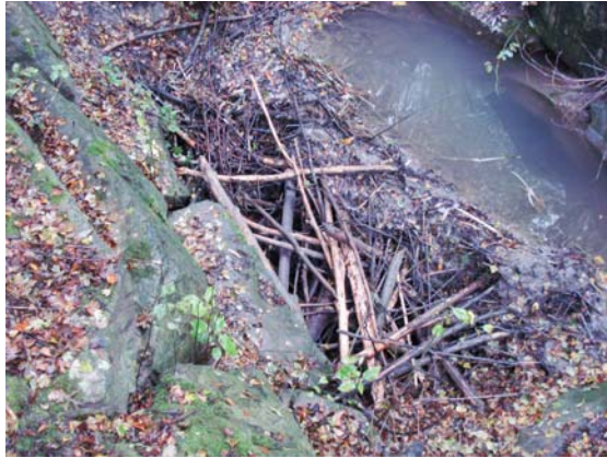
Abb.5.1. Eine Ansammlung von Material in einem Halbschalenrohr behindert den Abfluß aus einem Retentionsbecken (li), das Material wurde händisch entfernt (re). ©G.Hölzler
