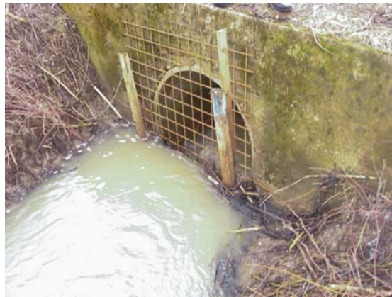
Abb.5.8. Senkrecht stehende Gitter an Auslaufbauwerken erleichtern das Abdichten einer Öffnung und sind schwer zu reinigen. ©G.Hölzler
