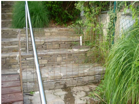
Abb. 7.8. Lösungen mit Baustahlgitter: Absperrung einer Treppe mit einem Tor (li.), Aufstellen eines Zauns (re.). ©G.Hölzler
