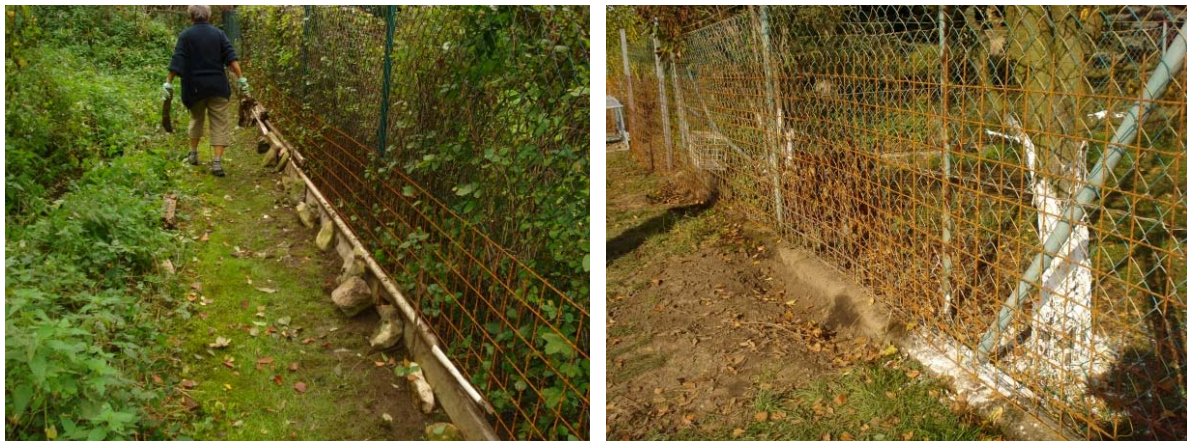
Abb.7.5. Dicht am Boden aufliegende Befestigungen wie Holzplanken oder Streifen von Baustahlgitter verbessern die Schutzwirkung von Zäunen. Holzplanken sollten dabei mit einer zusätzlich angebrachten Drahtauflage geschützt werden. ©G.Hölzler
