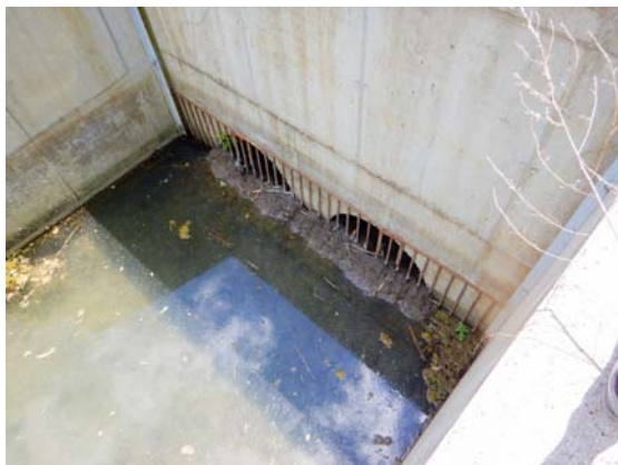
Abb.5.3. An einem Straßendurchlass wurde zum Schutz der Rohre ein senkrechte Gitter montiert (li), ein Dammdurchlass wurde durch das vom Biber aufgetürmte Material verlegt (re). ©G.Hölzler
