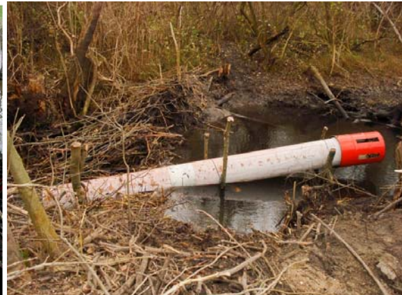
Abb. 4.10. Eine bis heute funktionierende Lösung sind 2 Rohre mit rundum geschlossenen Gitterkörben (li), genauso wie ein glattes Rohr mit 50cm Durchmesser (re). Statt einem Gitterkorb wurde hier ein geschlitztes Blechfass mit einer quer durchgesteckten Eisenstange zur Befestigung am Rohreinlauf angebracht. ©G.Hölzler
