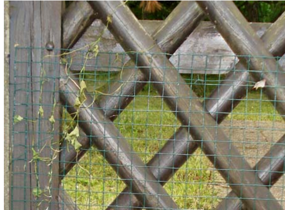
Abb. 3.11. Immer wieder nagen Biber Holzzäune an Grundstücksgrenzen durch und verirren sich in Privatgärten (li). Ein Holzgartenzaun wurde durch ein zusätzlich aufgebrachtes Drahtgitter geschützt (re). ©G.Hölzler
