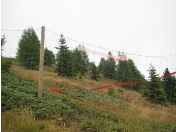
Abb. 60: Markierung eines Wildzaunes mit roten Bändern.
