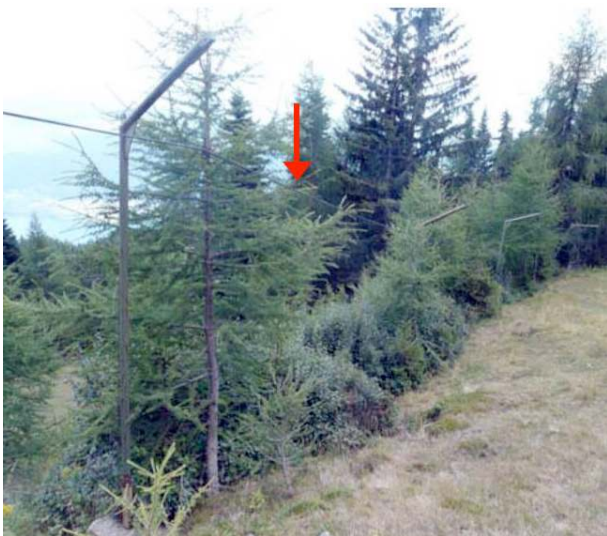
Abb. AIII-6: Zäune, die an/quer zur/unter der Geländekante verlaufen, bergen eine erhöhte Kollisionsgefahr. Fallbeispiel: Seil für ein Sicherungsnetz entlang einer Piste. Das Sicherungsnetz wird nur im Winter angebracht.
