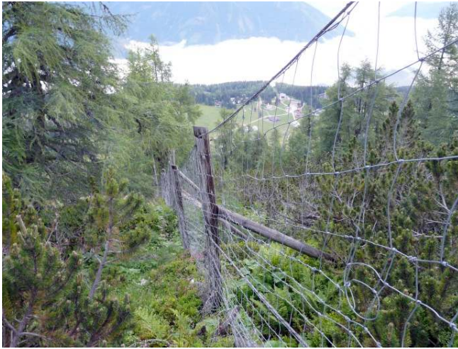
Abb. AIII-1: Der Wildzaun durchschneidet ausgezeichneten Birkhuhn-Ganzjahreslebensraum. Eine Verblendung wäre hier dringend zu empfehlen.
