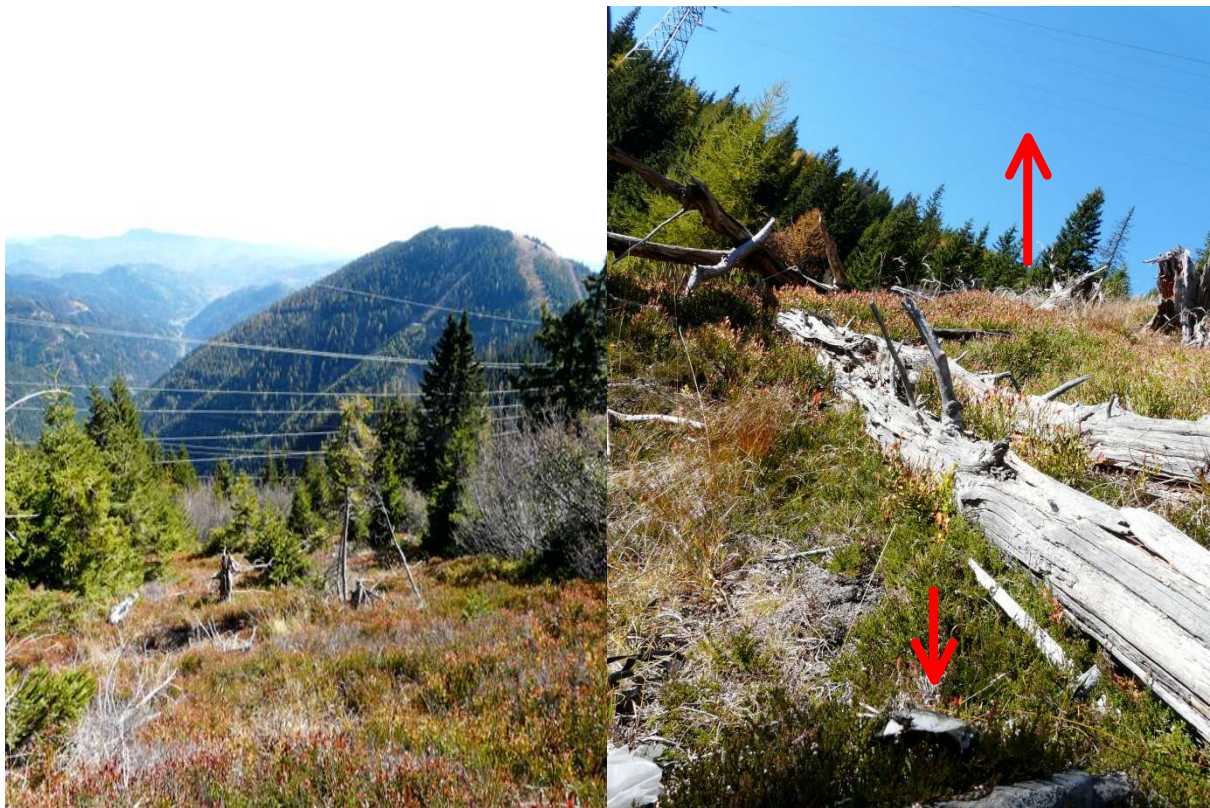
Abb. AIII-17: Freileitungen queren einen Hang mit sehr gutem Birkhuhn-Lebensraum. Die vielen übereinander angebrachten Leitungen in verschiedenen Höhen über einen großen Bereich bergen für Raufußhühner eine extrem hohe Kollisionsgefahr. Foto rechts: Überreste einer Birkhenne, die mit hoher Wahrscheinlichkeit mit den Leitungen kollidierte.
