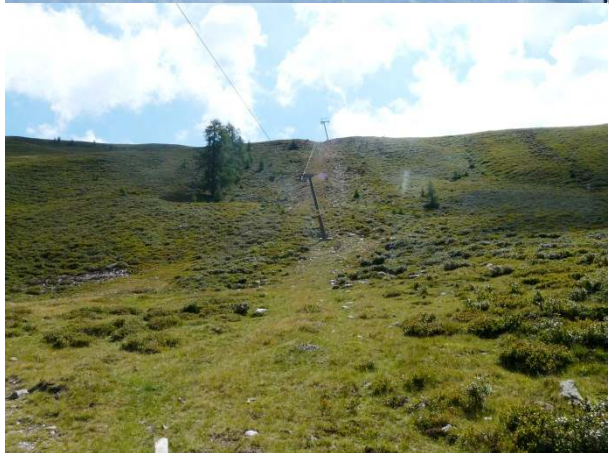
Abb. AIII-15: Seilführungen über Geländekanten bringen die Seilhöhe in von Raufußhühnern bevorzugt beflogene Bereiche.
