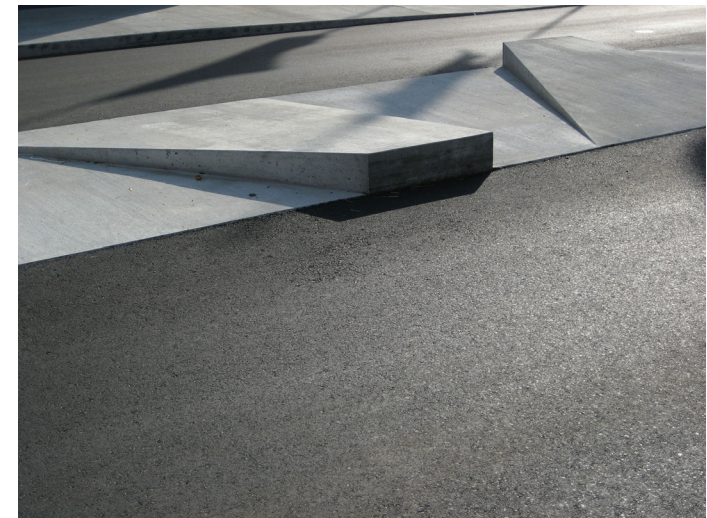
Stadlerstrasse Weiach (CH)
