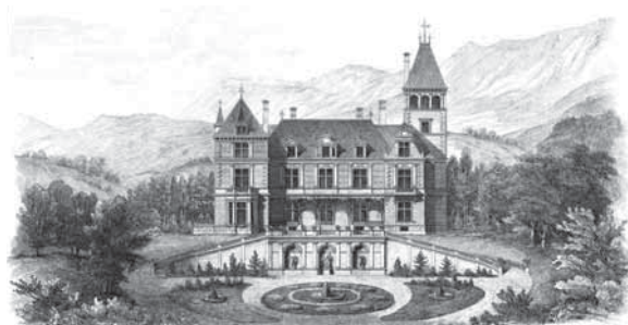
Abb. 01: Reichenau an der Rax, Villa Warholz des Erzherzog Karl Ludwig, ab 1870 von Architekt Heinrich von Ferstel: Als Jagdschloss des Hochadels konnten weder auf eine Repräsentationsfassade im Neo-Renaissance Stil noch auf eine neobarocke Parkgestaltung verzichtet werden. Abbildung aus: >Allgemeine Bauzeitung<, Wien 1877
