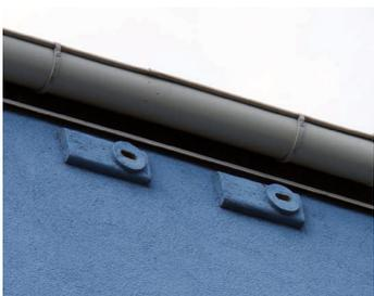
Nistkästen für Mauersegler die in das Wärmedämmverbundsystem integriert sind
