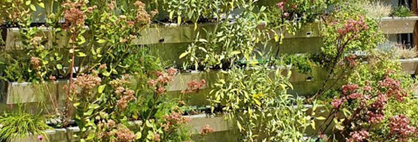
Fassadenbegrünung mit linearen Trögen
