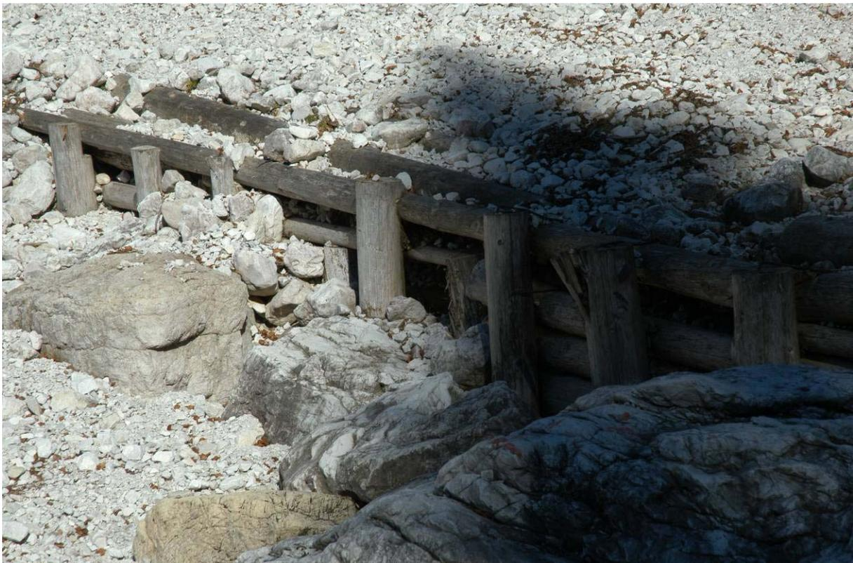
Abbildung 14: Beispiel eines „Elefantenzaunes“ zur Sicherung einer Furt (Mangartbach)
