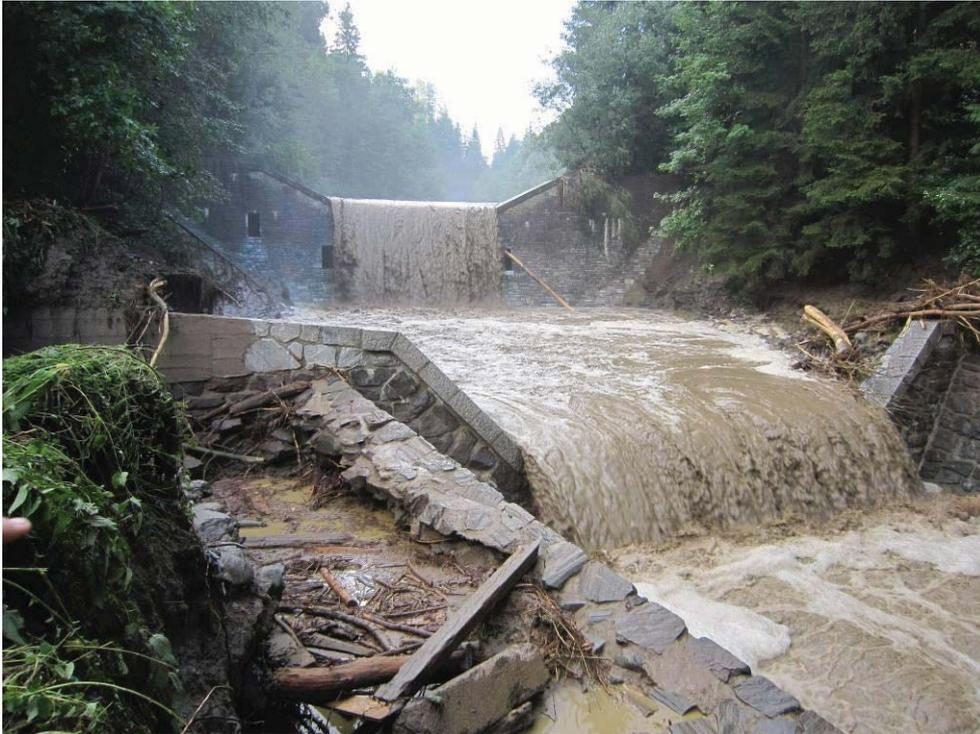
Abbildung 42: Hintereggerbach - Sperre bei hm 5,5 mit Erosion der Ufermauern
