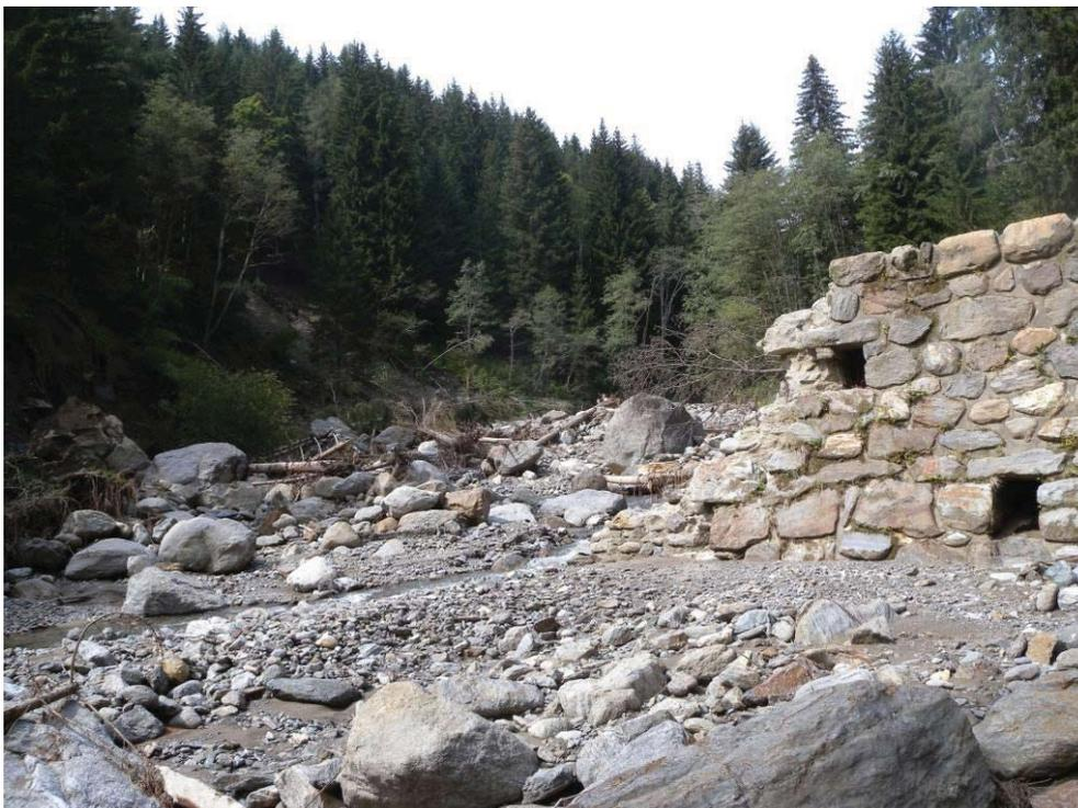
Abbildung 40: Schöttlbach - Fragmente der zerstörten Steinsperre bei hm 52,4
