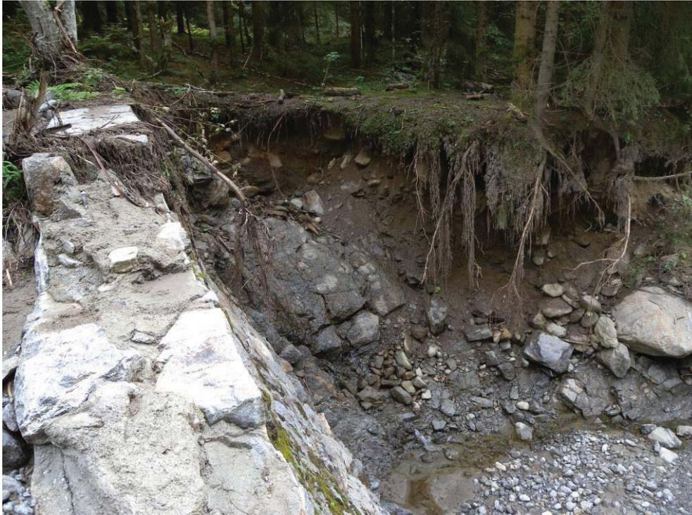
Abbildung 39: Schöttlbach - Seitenerosion unterhalb der Sperre bei hm 37,1
