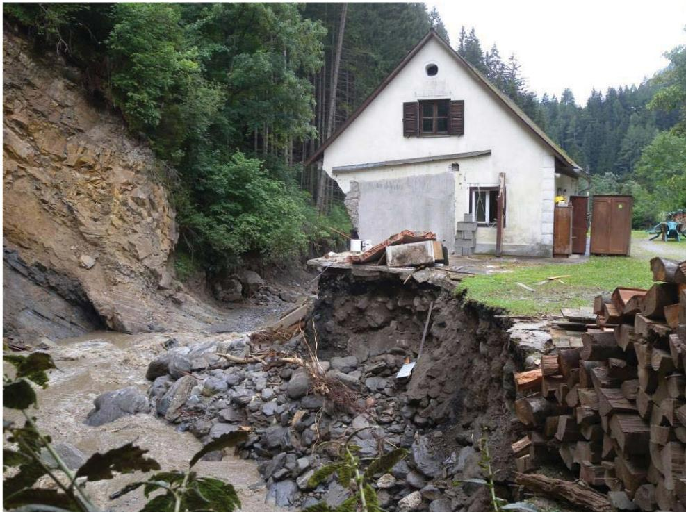
Abbildung 38: Schöttlbach - Blick bachabwärts der Sperre bei hm 25,7, massive Seitenerosion
