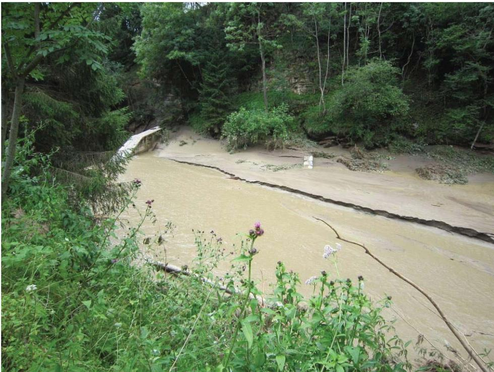
Abbildung 43: Hintereggerbach - Verlandungsraum der Sperre bei hm 5,5 mit kaum sichtbarer Vorsperre
