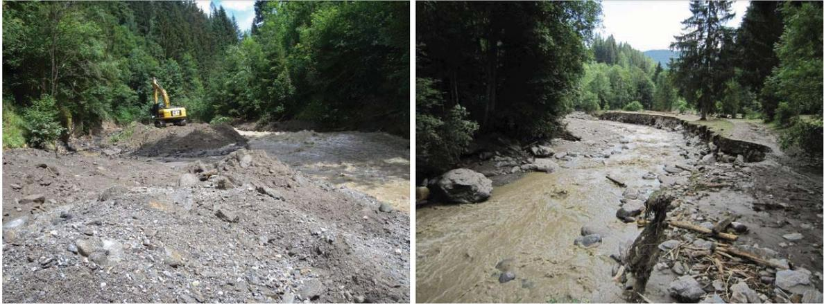
Abbildung 14: Schöttlach Unterlauf - Ablagerung bei verschütteter Wehranlage hm 27,0 (linkes Bild); Seitenerosion hm 23,0 (rechtes Bild)
