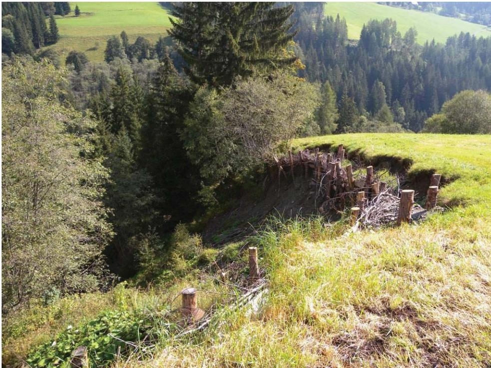
Abbildung 25: Hintereggerbach - Anrisskante einer Rutschung hm 59,9
