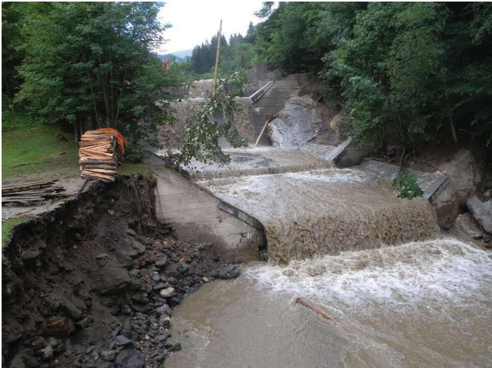
Abbildung 37: Schöttlbach - Sperre mit Vorsperre und Sohlgurt sowie Bogensperre bei hm 25,7
