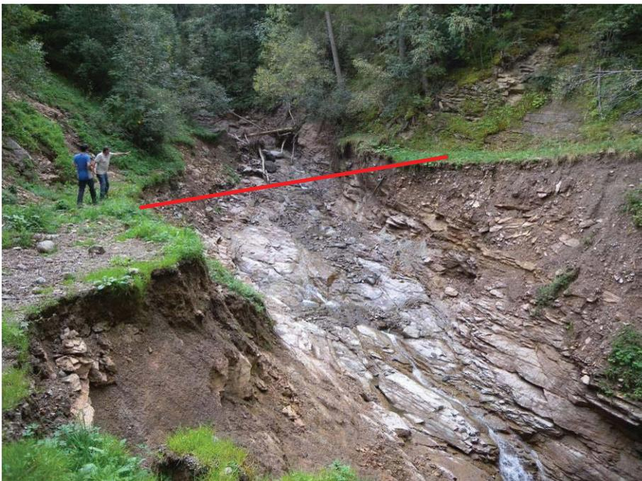
Abbildung 19: Hintereggerbach - massive Gerinneerosion im linksufrigen Zubringer Wöhrybach (Mündung bei hm 41,3), die rote Linie stellt den ursprünglichen Geländeverlauf dar
