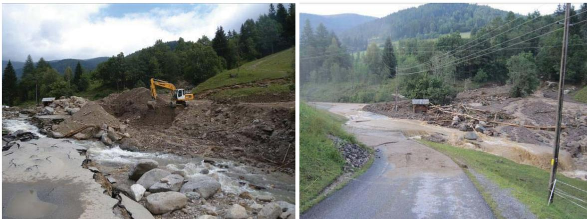
Abbildung 20: Hintereggerbach – Ablagerungen durch linksufrigen Zubringer Wöhrybach und Verlegung des Hauptgerinnes hm 41,3
