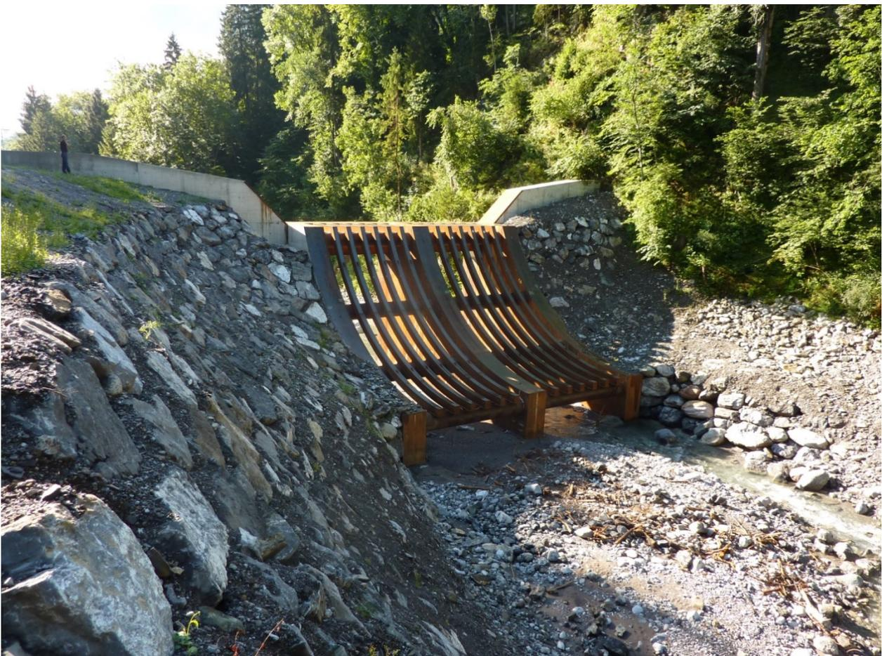
Abbildung 3: Rechensperre mit ausgerundeten MSH Stahlträgern;
