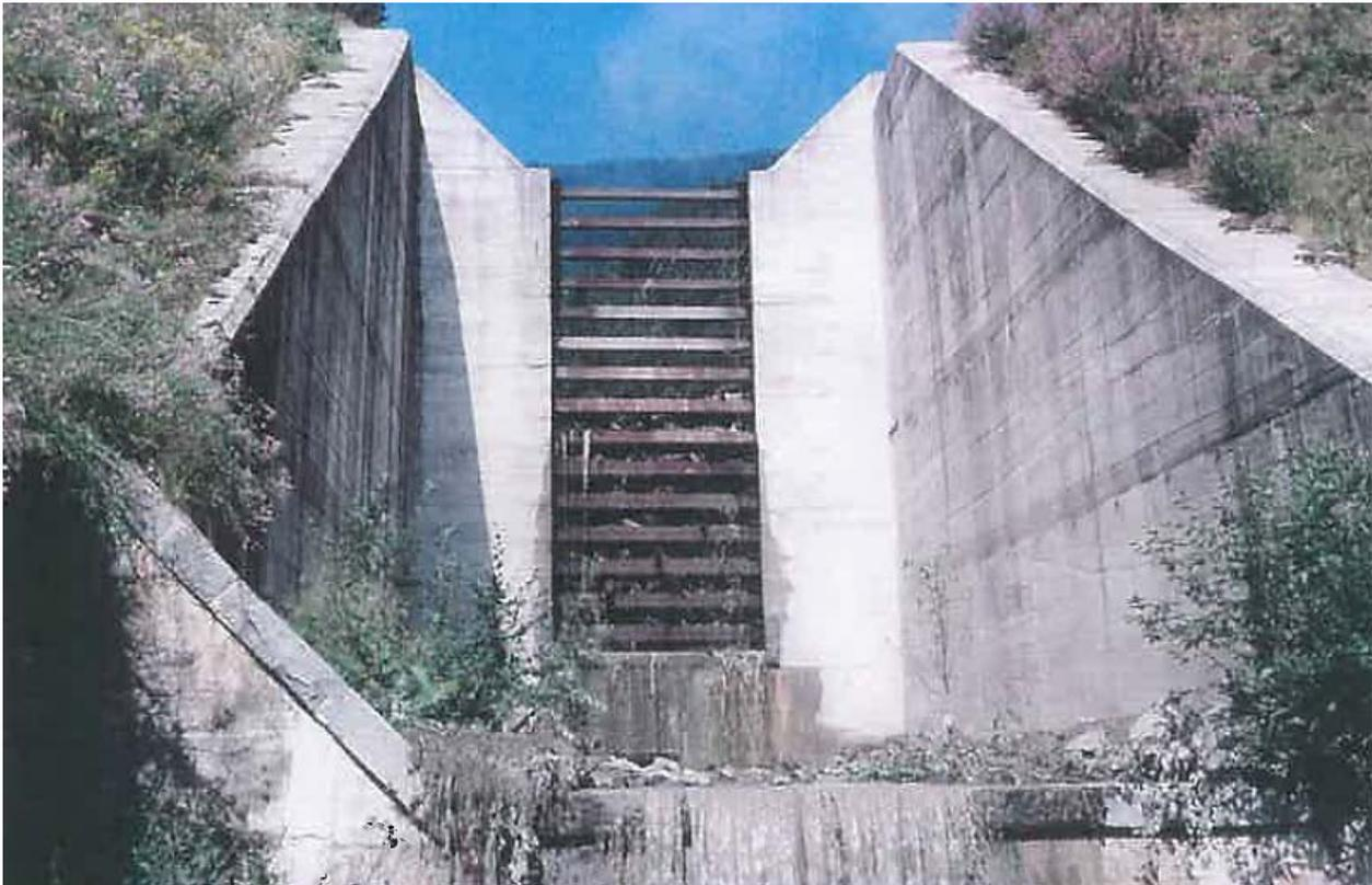
Abbildung 2: Kombination aus einer Schlitz- und einer Balkensperre; Quelle: (WEBER, 2006)
