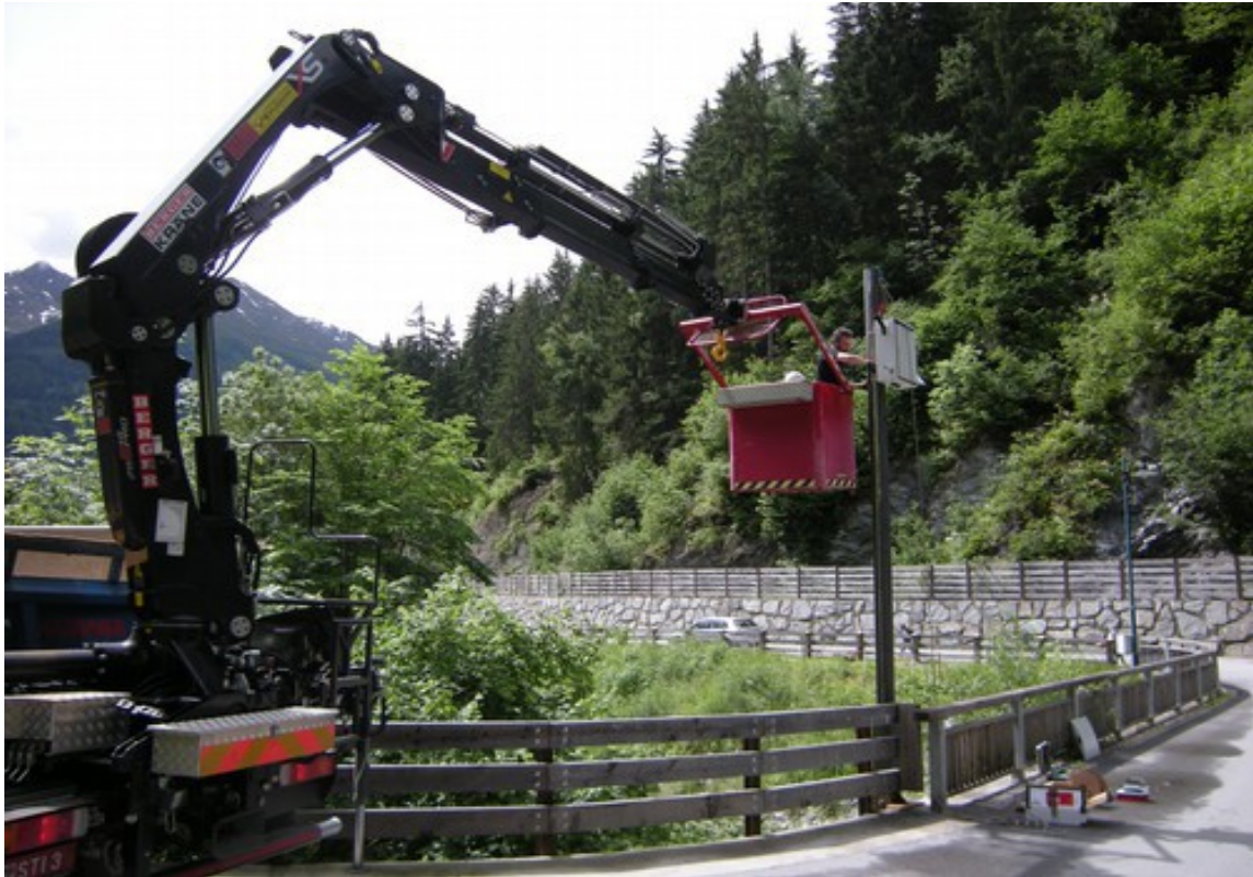
Abbildung 13: Montage des Radars am Standort
