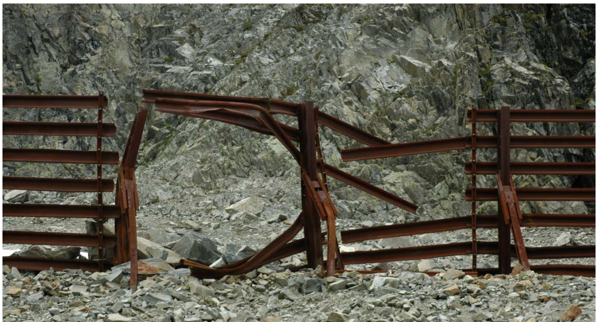
Abbildung 1: Zerstörung einer Stahlschneebrücke infolge eines Steinschlages
