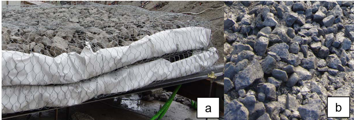
Abbildung 12: Dämpfungsmaterial eingebaut a., und lose b.
