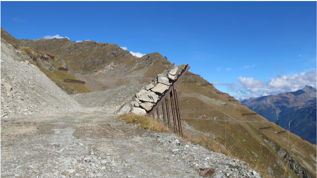
Abbildung 2: Stahlschneebrücke mit Überdeckung (WLV Vorarlberg).
