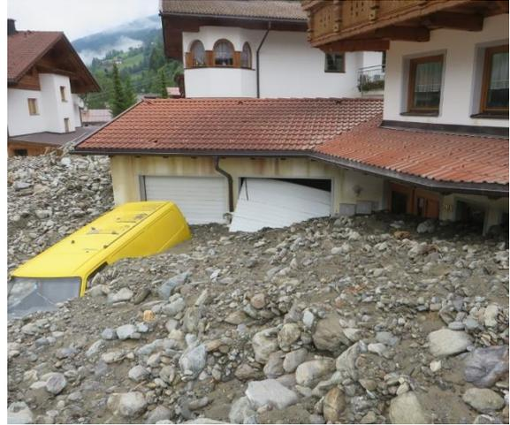
Abbildung 47: Vermurung von Keller- und Erdgeschoß im Ortsteil Grieß (Quelle: WLV)
