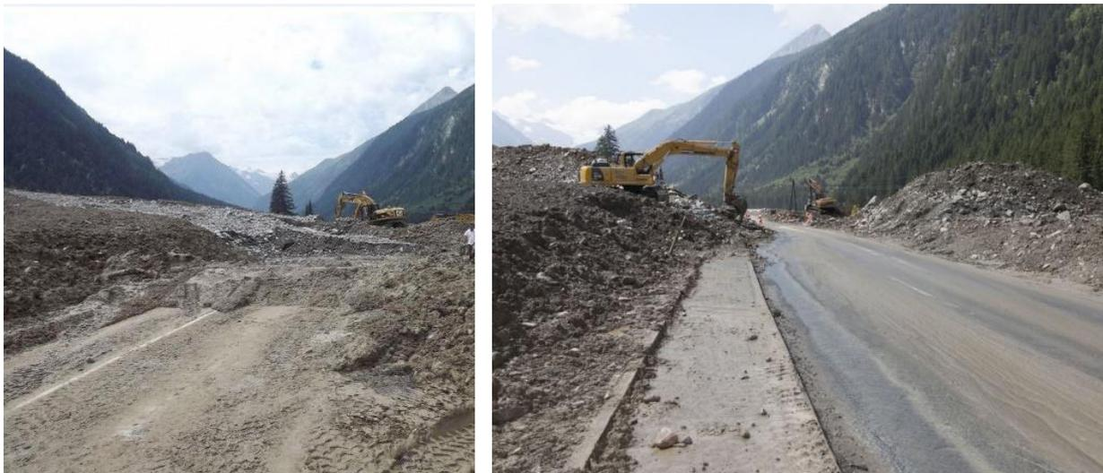
Abbildung 105: Aufräumarbeiten der Ablagerungen des Mischbaches auf der L232 Ranalter Straße
