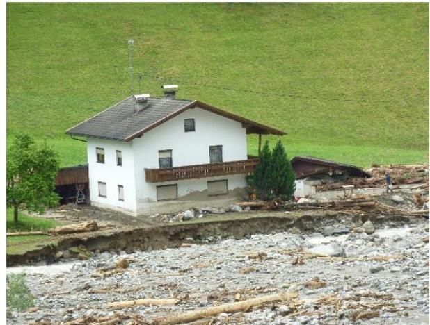
Abbildung 83: Links: durch Überschotterung zerstörtes Nebengebäude; Rechts: durch die Ablagerung des Seigesbaches wurde die Melach orografisch nach links verdrängt, wodurch die linksufrige Böschung bis nahe zur Hauswand erodiert wurde (Quelle: WLV)
