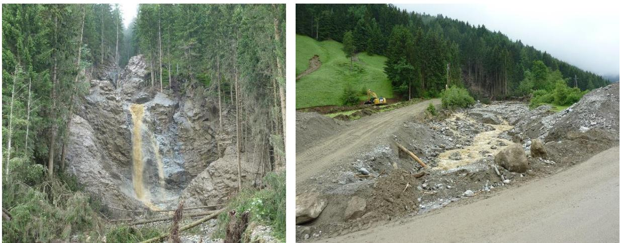
Abbildung 80: Links: Ende der Schluchtstrecke mit deutlich erkennbaren Anschlagmarken; Rechts: das Einlaufgerinne unterhalb der Schluchtstrecke wurde total zerstört (Quelle: WLV)
