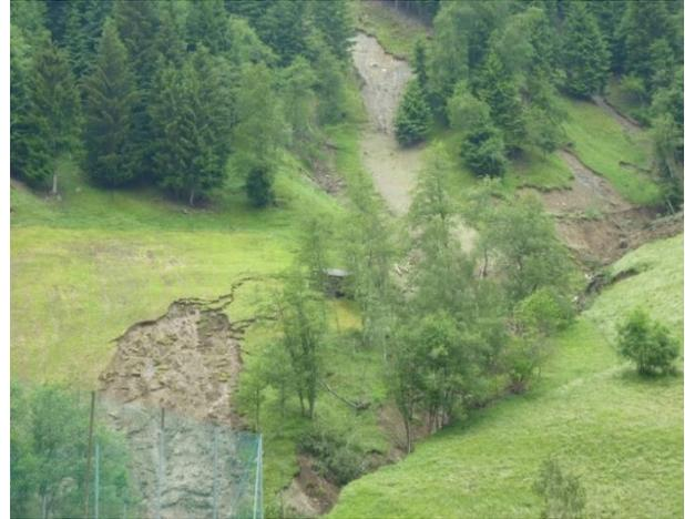
Abbildung 81: Im Talbereich kam es durch die starke Durchnässung des Bodens zu zahlreichen Hangrutschungen (Quelle: WLV)
