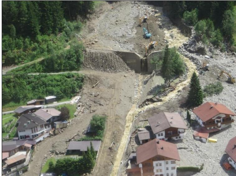
Abbildung 27: Geschieberückhaltesperre bei hm 3,93. Das Rückhaltebecken war zum Zeitpunkt des Dammversagens auf der orografisch linken Seite zur Gänze verfüllt (Quelle: WLV)
