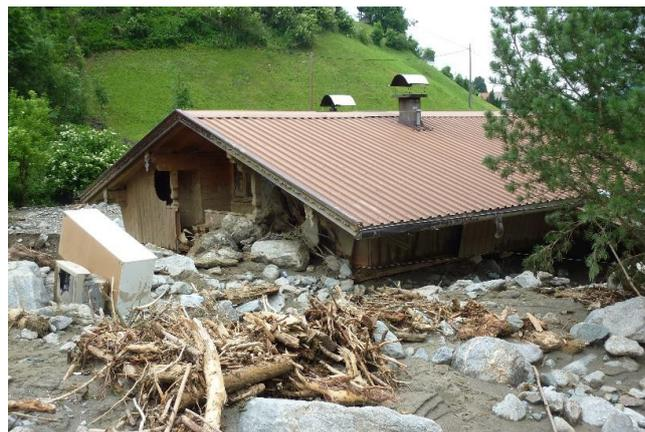
Abbildung 74: Bis zum Dachstuhl verschottertes Haus im Mündungsbereich des Ellmauerbachs durch die Prozessaktivität am Seigesbach (Quelle: WLW)
