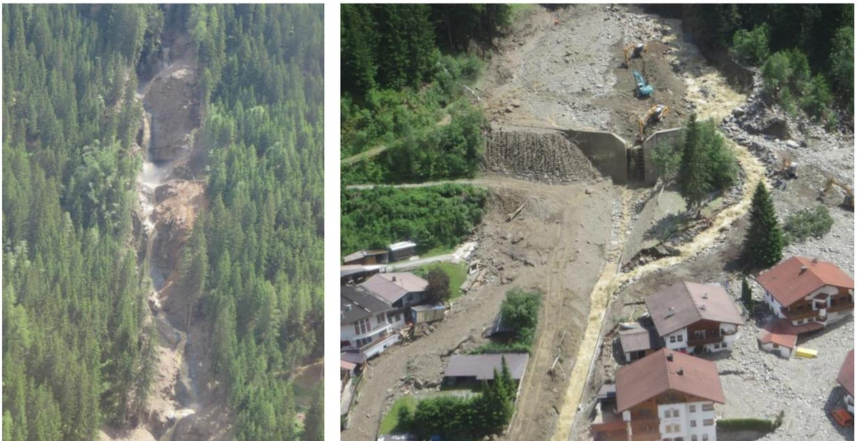
Abbildung 54: Links: Schluchtstrecke mit mehreren aufeinanderfolgenden Wasserfällen zwischen hm 4,9 und hm 7,7; Rechts: Überblick Geschieberückhaltesperre mit Bachverlagerung durch den erodierten Damm (Quelle: WLW)
