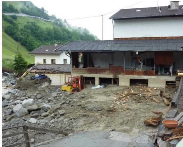
Abbildung 82: Links: Ablagerung und Anschlagmarken an einem Wohnhaus; Rechts: hohe Ablagerungen und durch die Fluten teilweise weggerissenes Nebengebäude führten zu starker Beschädigung des Sägewerkes (Quelle: WLV)
