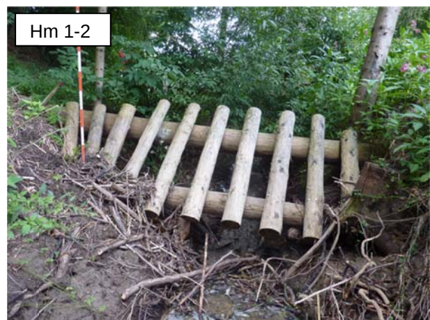
Foto in Flierichtung: Wildholzrechen im Hummelberggraben oberhalb des Zusammenflusses mit dem Braunsbergbach.
