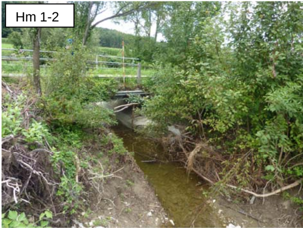
Foto in Fließrichtung: Brücke des Radweges entlang des Stössingbaches kurz vor der Mündung des Angerbaches war teilverklaust und konnte Ereignisabfluss nicht aufnehmen.
