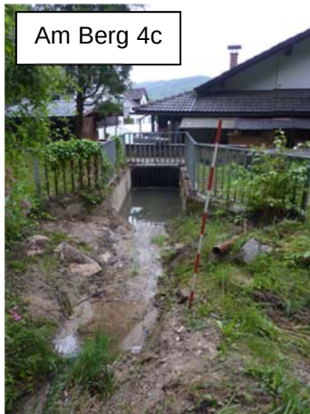
Foto in Fließrichtung: kleiner Rechen und Absetzbecken vor Verrohrung unter dem Siedlungsgebiet ist im Ereignisfall verklaust und überlastet.
