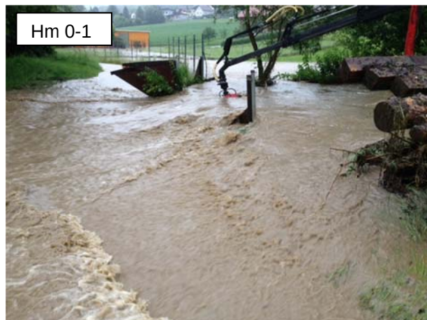
Foto zeigt den gleichen Durchlass bei der Räumung.
