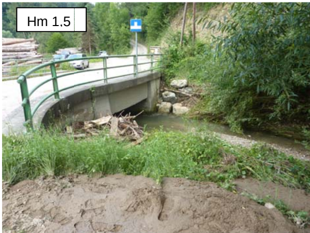
Brücke gegenüber der Liegenschaft Deutschbachstraße 2.
