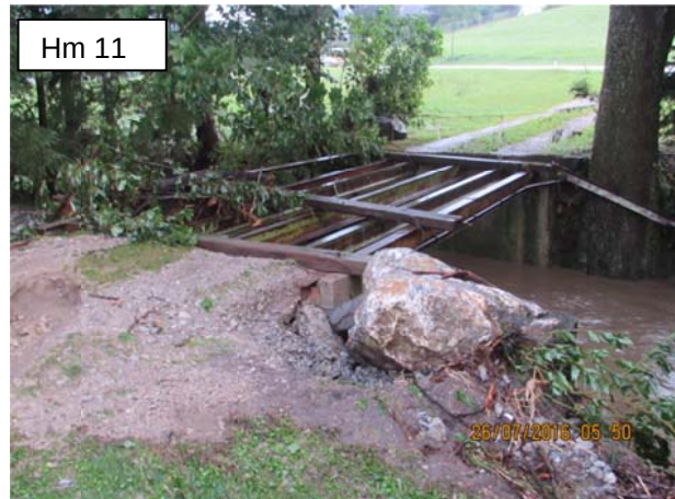
Der Zufahrtsweg zur Liegenschaft Kilber-Straße 5 war beim Ereignis verklaust. (Quelle: Fam.Seitz)
