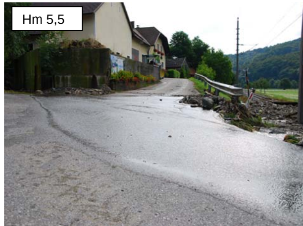
Das Foto zeigt die Verklausungsstelle. (Quelle: M. Scholze-Simmel)
