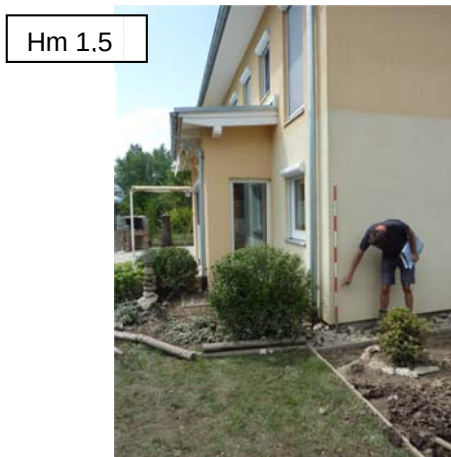
Anschlagmarke auf der Liegenschaft Deutschbachstraße 2.
