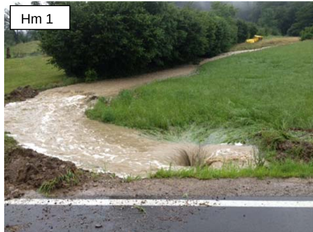
Foto entgegen der Fließrichtung: Schacht an der L110, nachdem die Anrainer das Gerinne ausgebaggert und das Gitter entfernt haben. (Quelle: Leopold Kasseckert)
