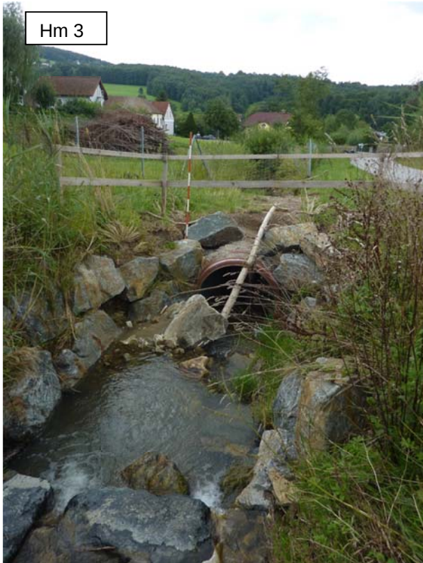
Foto in Fließrichtung: Beim Ereignis teilverklauster Rohrdurchlass flussaufwärts der L110.
