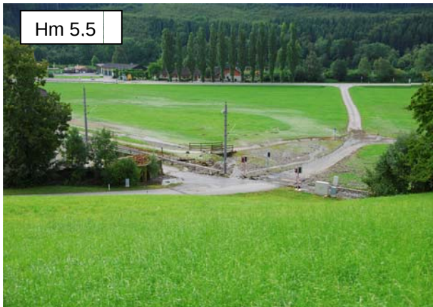
Foto in Fließrichtung: Am Ende der Betonmauer links befindet sich die komplettverklauste Durchführung des Gerinnes. Auch die Durchführung unter dem Bahnkörper ist verklaust. (Quelle: M. Scholze-Simmel)
