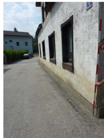
Anschlagmarke bei der Liegenschaft Bösendörfl 4. Vor dem Haus im Hintergrund befindet sich das Gerinne des Grubtalgrabens, der dort von rechts kommt.
