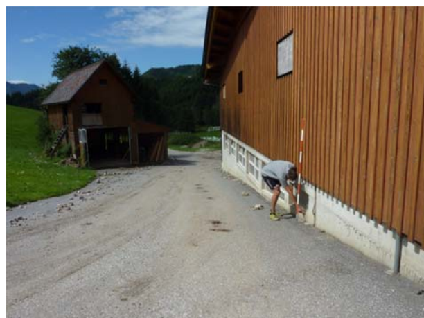
Anschlagmarke am Stallgebäude der Liegenschaft Fürtleben 9, die sich aus dem Oberflächenabfluss aus Richtung Schneekogel ergibt.
