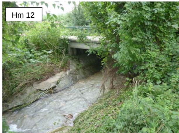
Foto entgegen der Fließrichtung: Brückendurchlass ohne Verklausung.
