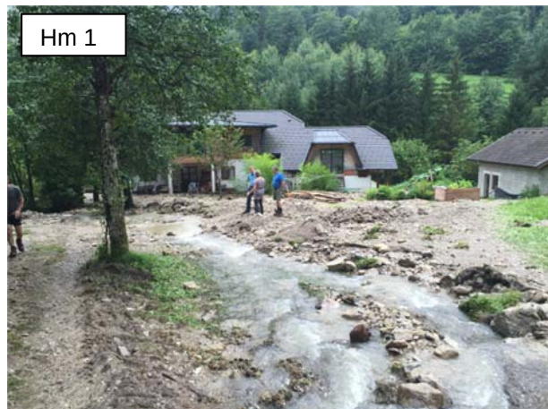
Foto in Fließrichtung: Im Ereignisfall verklaust der Rohrdurchlass bei hm 0,7, verlandet und führt zum Ausbruch des Ereignisabflusses über die Grünfläche Richtung Wohnhaus. Dabei kommt es auch zur Geschiebeablagerung.
