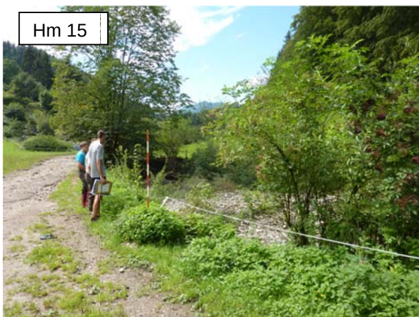
Foto in Fließrichtung: kleines Retentionsbecken bei hm 15.
