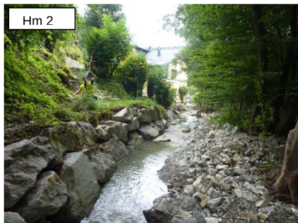
Foto in Fließrichtung: Gerinne des Ober Hammerschmidgrabens bei der Liegenschaft Zell 18.
