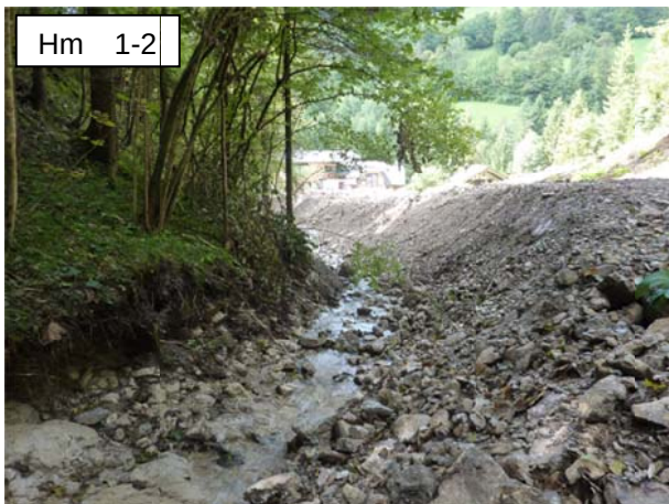
Foto in Fließrichtung: nach dem Ereignis wurde das Gerinne vertieft und ein Wall aufgeschüttet.
