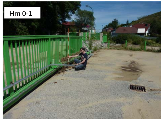
Freifläche der Liegenschaft Grubmühlstraße 1. Die anliegenden Gebäude waren nicht betroffen.
