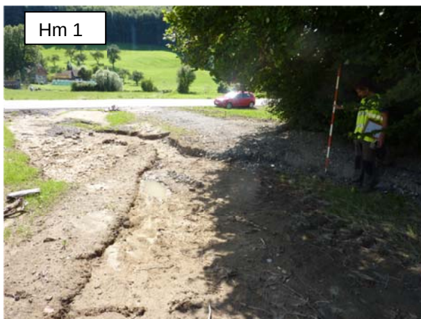
Foto in Fließrichtung: Erosion und Ablagerung von feinem Material oberhalb der L110.
