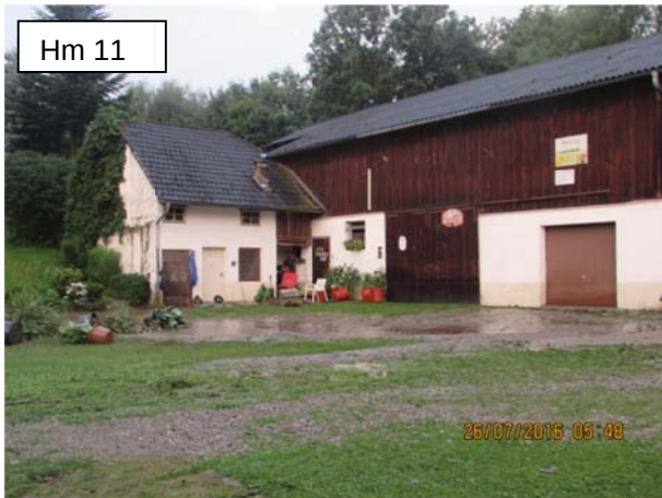
Foto zeigt den Überschwemmungsbereich bei der Liegenschaft Kilber-Straße 5. (Quelle: Fam.Seitz)
