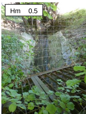
Foto entgegen der Fließrichtung: Wildholzgitter beim Einlauf in die Verrohrung zeigt keinerlei Verklausung oder Überlastung.
