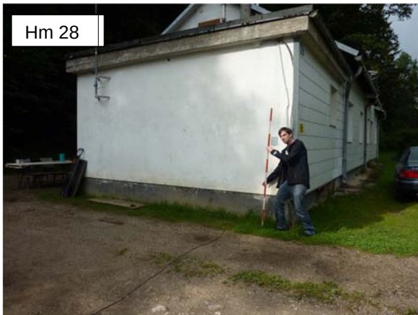
Anschlagmarke beim Wohngebäude der Liegenschaft Grünsbach 75.
