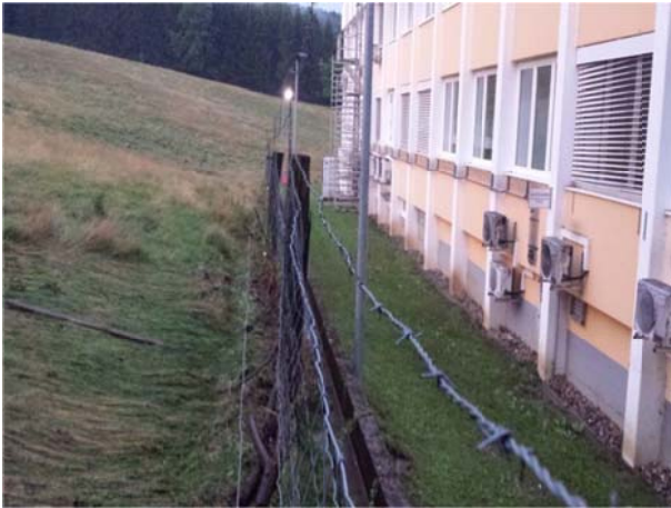
Weidezaun oberhalb der Constantia Teich GmbH. Hier trifft der Ereignisabfluss auf das Firmengebäude. Hier wird entlang der Betonmauer und des Gebäudes in Blickrichtung abgelenkt und trifft dort auf die Überflutungsfläche aus dem Tannenbach. (Quelle: WLV Melk)
