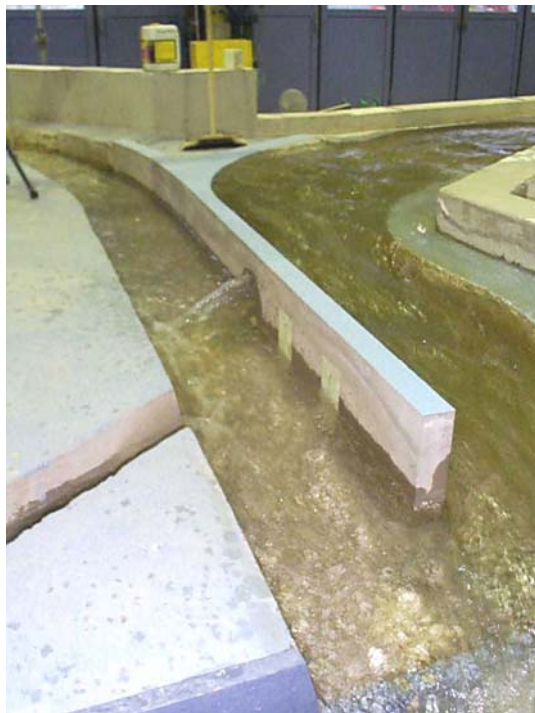
Abb. 45: Blick vom 1. Absturzbauwerk nach flussauf; V.1.G.1.3
