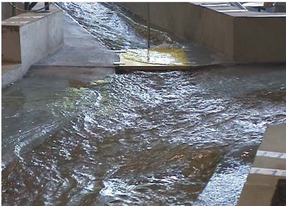
Blick vom ersten Absturzbauwerk flussauf
