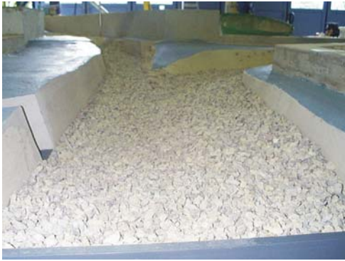
ISF-Zustand, Blick vom Absturzbauwerk nach flussauf
