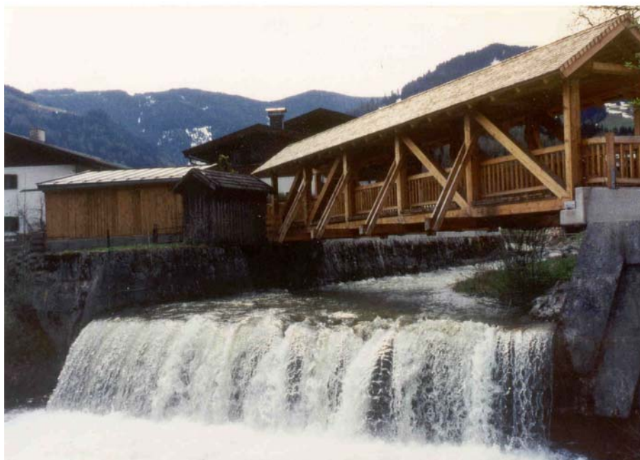
Abb. 14: Absturzbauwerk 1; Blick flussauf
