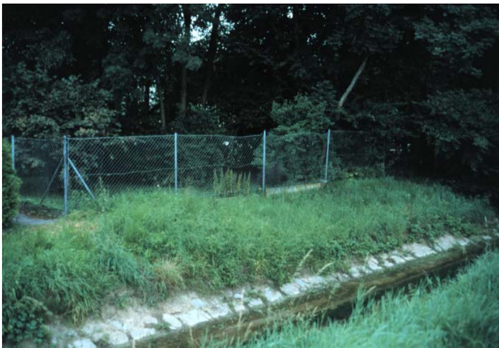
Foto 4: Kritischer Bereich nördlich des Gebäudes bei den Stockbahnen (Mittellauf)
