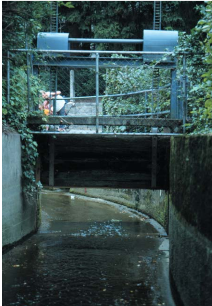
Foto 7: Schütz in der Künette südlich von Maria Anger, Blickrichtung bachabwärts
