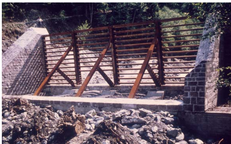
Abbildung 9: Balkensperre im Riedbach in Tirol (Foto: WLS-Archiv)
