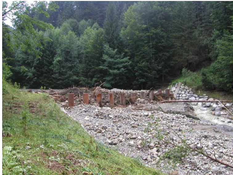
Abbildung 11: Wildholzrechen im Fischbach, Salzburg (Foto: Wehrmann)
