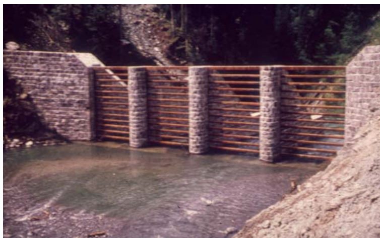
Abbildung 6: Sortiersperre im Märzenbach im Zillertal (Foto: WLS-Archiv)
