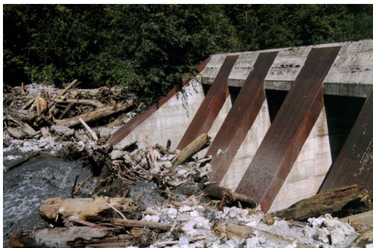
Abbildung 8: Murbrecher im Luggauerbach, Salzburg (Foto: Hübl)
