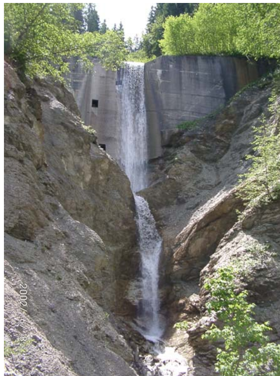
Abbildung 4: Konsolidierungssperre am Rettenbach in Tirol (Foto: Holub)
