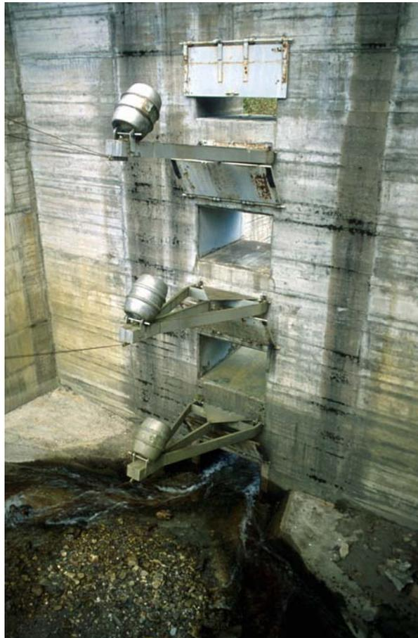
Abbildung 59: Gesteuerte Kleindolensperre, Detail Steuermechanismus (Wasserdosierwerk im Reitalpsbach, Salzburg; Foto: Hübl)
