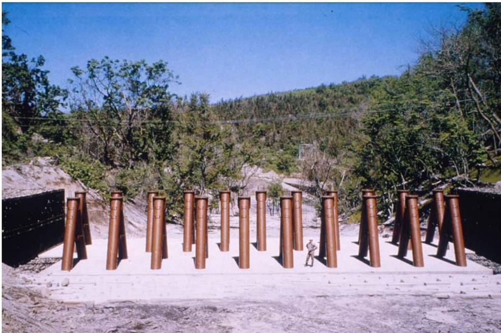
Abbildung 34: Offene aufgelöste Sperre mit 21 Pfeilern (Japan, Foto: WLS Archiv)
