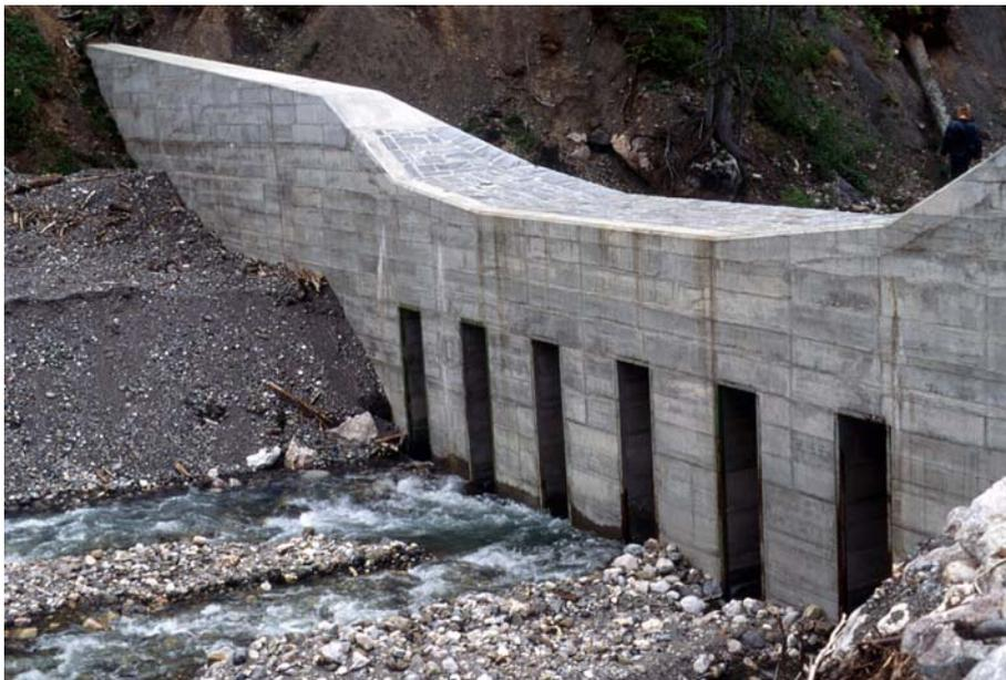
Abbildung 23: Kronengeschlossene Offene Schlitzsperre mit 6 senkrechten Schlitzen (Oselitzenbach, Kärnten; Foto: Hübl)
