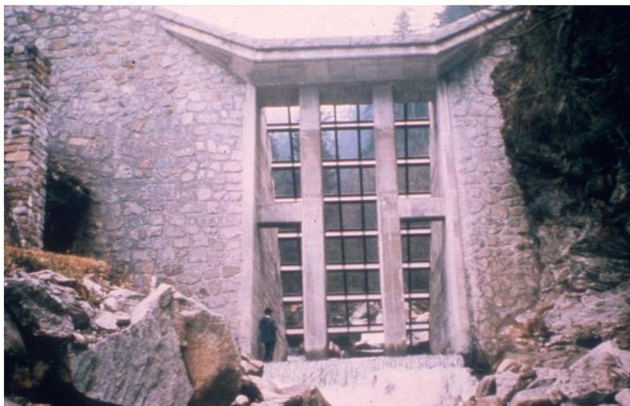
Abbildung 14: Beispiel für mehrere Öffnungen mit unterschiedlicher Geometrie (Mayerhofgraben, Salzburg; Foto: WLS Archiv)
