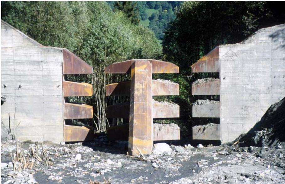
Abbildung 60: Kronenoffene Offene Kreuzschlitzsperre mit Murteiler (Luggauerbach, Salzburg; Foto: Hübl)
