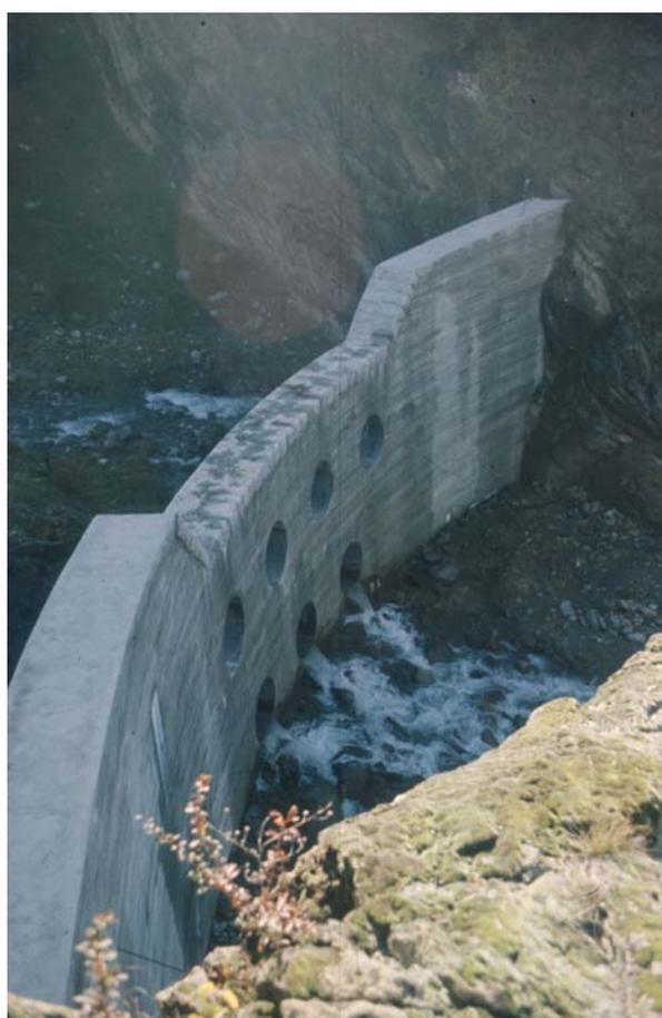
Abbildung 19: Offene Bogenförmige Kleindolensperre mit 7 Dolen (Südtirol, Foto: WLS Archiv)
