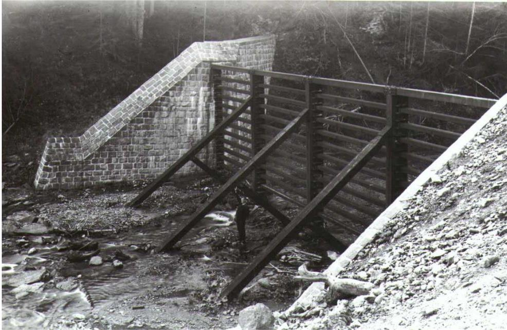
Abbildung 33: Aufgelöste-Balkensperre mit 3 Streben (Riedbach, Tirol; Foto: WLV)
