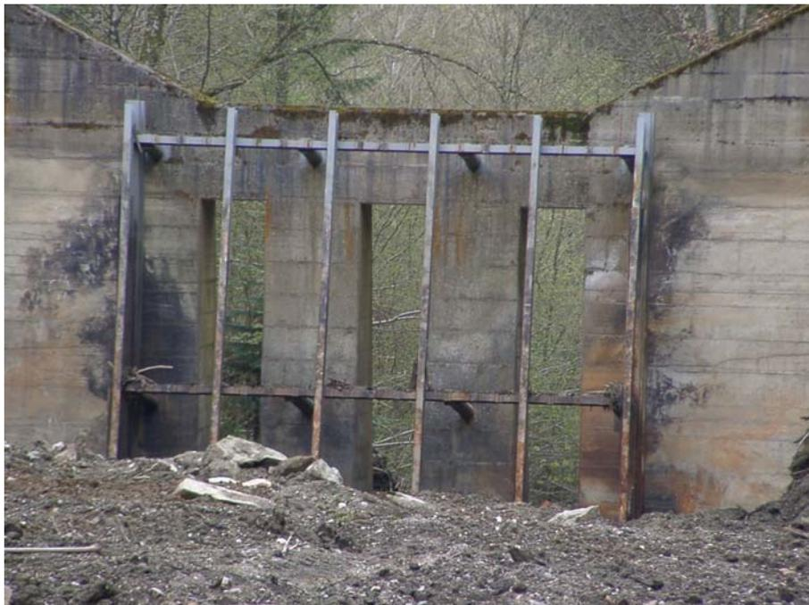
Abbildung 47: kronengeschlossene Schlitz-Rechensperre mit drei senkrechten Schlitzen und vorgeschaltetem Rechen (Trixenbach, Kärnten; Foto: Holub)
