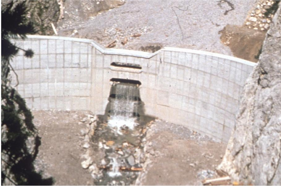
Abbildung 22: Bogenförmige Kronengeschlossene Offene Schlitzsperre mit 4 waagrechten Schlitzen (Schnannerbach, Tirol; Foto: WLV)
