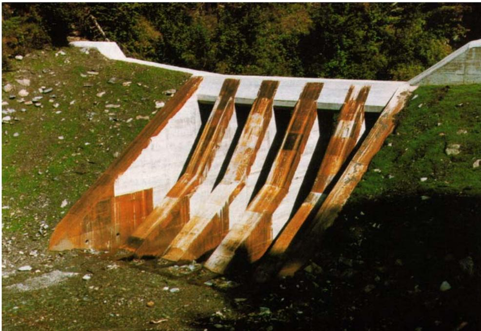
Abbildung 58: Kronengeschlossene Offene aufgelöste Sperre mit 4 Scheiben (Murbrecher Luggauerbach, Salzburg; KETTL 1984)
