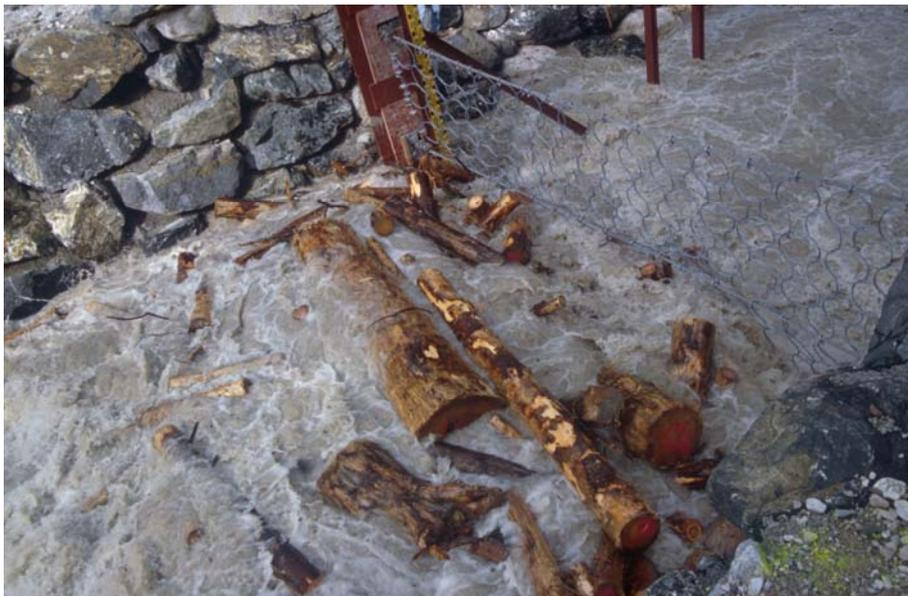
Abbildung 41: Netzsperrre (Versuchsnetz (RIMBÖCK, 2002) im Lobentalbach, Bayern; Foto: Hübl)
