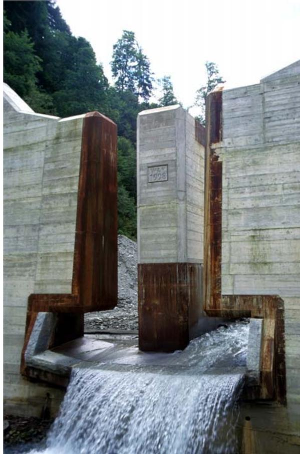
Abbildung 53: Kronenoffene Offene Schlitzsperre mit 2 L-förmigen Schlitzen und vorgesetztem Murteiler (Löhnersbach, Salzburg; Foto: Hübl)
