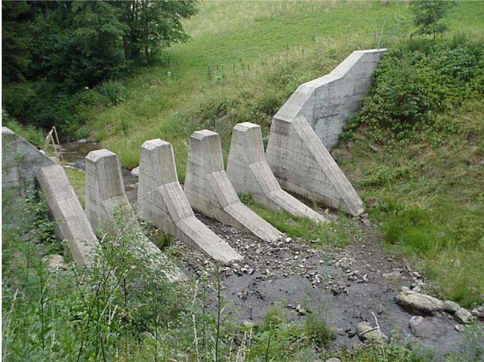
Abbildung 31: Offene aufgelöste Sperre mit 4 Scheiben (Murbrecher im Gemmersdorferbach, Salzburg; Foto: Steinwendtner)
