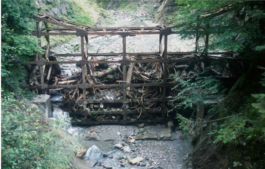
Abbildung 38: Räumliche Gittersperre (Kirchberggraben, Kärnten; Foto: WLS Archiv)
