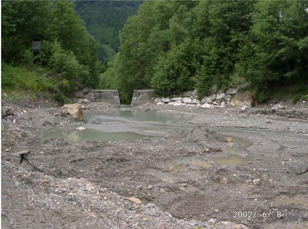
Abbildung 43: Kronenoffene Offene Schlitzsperre mit einem V-förmigen Schlitz (Geschiebeablagerungsbecken im Rettenbach, Tirol; Foto: Holub)
