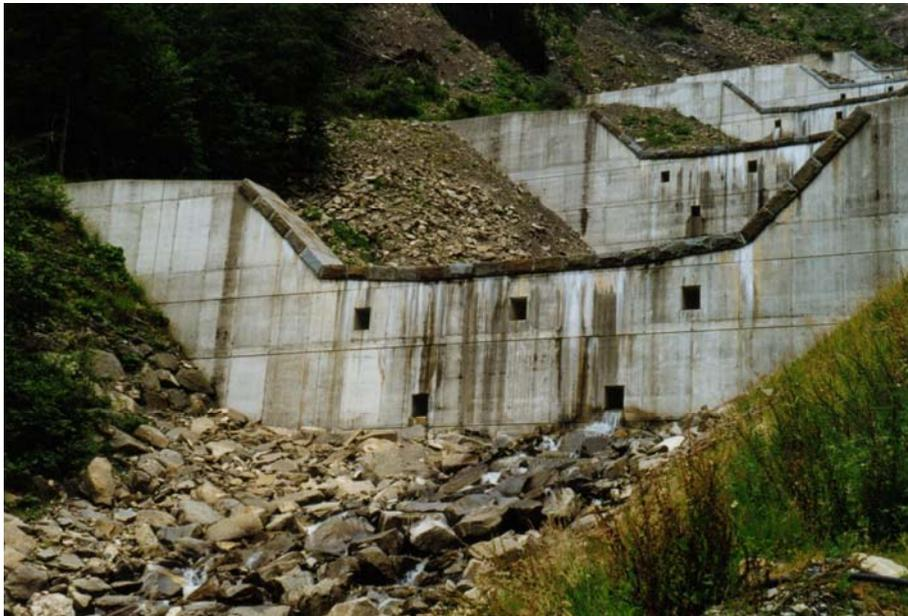
Abbildung 9: Reihe Einfacher Vollwandsperrren im Schrecksbach (Foto: Hübl)
