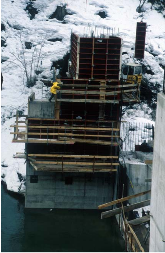
Abbildung 3: Linksufriger Sperrenflügel mit eingebauten Messwertgebern
