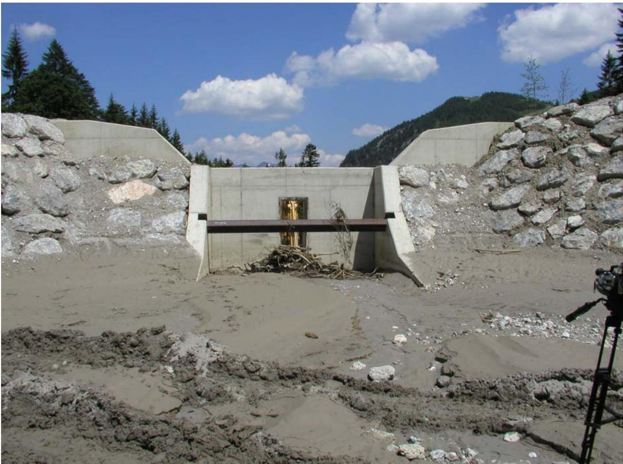
Abbildung 3: Ausleitungsbauwerk bei hm 35.96
