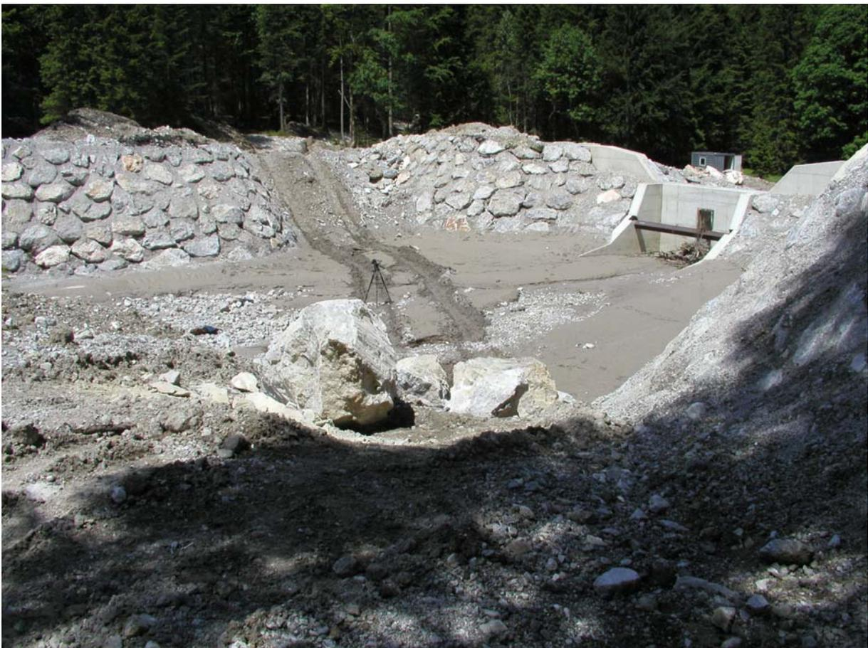
Abbildung 4: Ausleitung in die Flutmulde im Bauzustand
