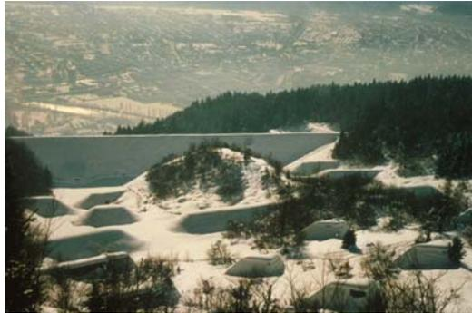
Abbildung 27: Bremsverbauung und Auffangdamm, ArzleralmLawine, Innsbruck, (WLV Innsbruck)
