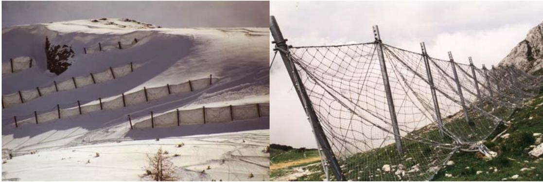
Abbildung 25: links: Schneenetze zur Sicherung einer Schipiste bzw. einer Aufstiegshilfe, Ischgl, (KREU, 2001); rechts: Schneenetze zur Sicherung einer Schipiste bzw. einer Aufstiegshilfe, Nassfeld, (KREU, 1998)
