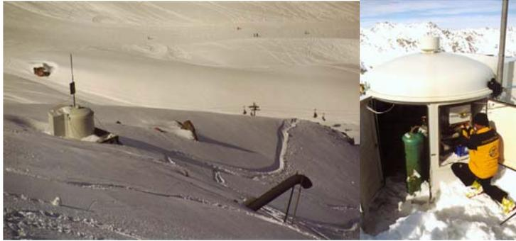
*Abbildung 37: links: Gazex in Ischgl – Versorgungscontainer links, Zündrohr rechts im Bild, (KREU, 2001); rechts: Gazex Versorgungscontainer, Ischgl, (KREU, 2001).*
