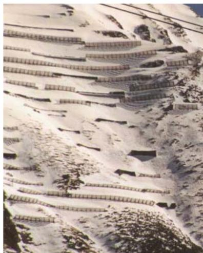
Abbildung 22: gegliederte und massive Werke in der Feuersangverbauung, Salzburg (KREU, 2002).
