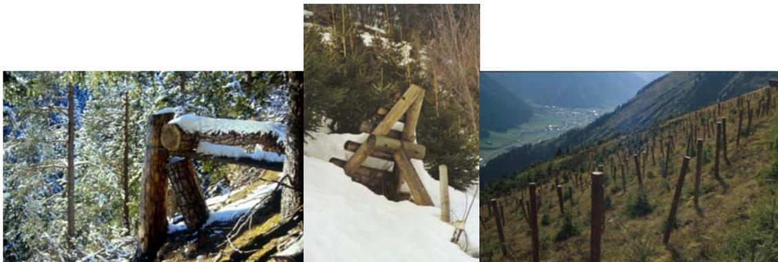
Abbildung 29: links: Querschlägerung, (ANFI Archiv); mitte: Gleitbock zum Schutz einer Aufforstung, Dienten, (KREU 2001); rechts: Verpfählung im Lawinenanbruchgebiet Adamsberg, Galtür, (JAN, 2000).
