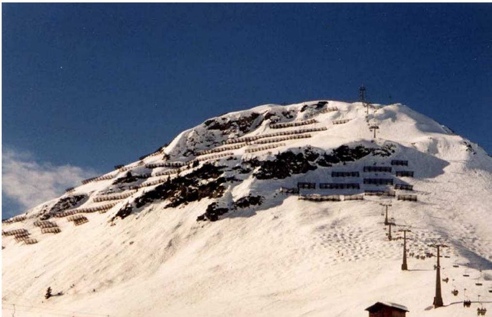
*Abbildung 80: Südhang des Kriegerhornes. Die Verbauung schützt sowohl die darunter befindliche Variantenabfahrt bzw. Schiroute, als auch Ortsteile von Lech (PÜR, 2002).*
