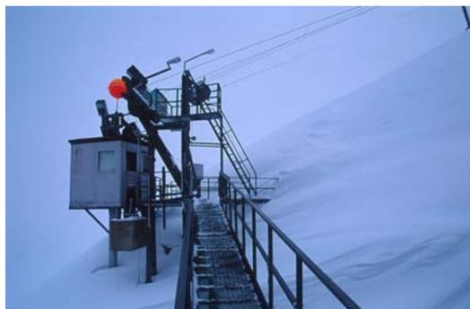
*Abbildung 34: Sprengseilbahn - Trittkopf in Zürs, (KREU, 2001).*
