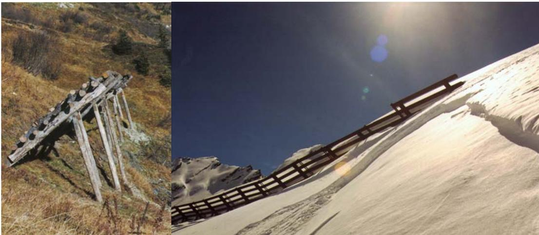
Abbildung 23: links: Holzschneebrücke in St. Anton/Arlberg, Gampen, (KREU, 1999); rechts: Stahlschneebrücke in Galtür, (KREU, 2001)
