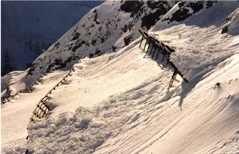
*Abbildung 81: Trotz den Verbauungsmaßnahmen können aus den Stahlschneebrücken Nassschneerutsche ausbrechen, welche für die Variantenabfahrt bzw. Schiroute eine Gefährdung darstellen (PÜR, 2002).*
