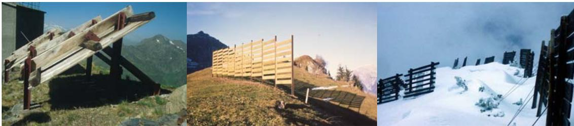
Abbildung 26: links: Winddüse, (HÜB, 1996); mitte: Schneezäun, (HÜB, 1996); rechts: Schneezäun und Kolktafel in Kombination, (FTD VLBG).
