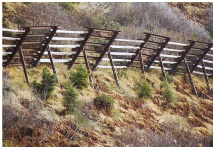
Abbildung 24: kombinierte Stahl-Holz Stützverbauung, Aufforstung Proxenlawine, Schwarz, (KREU, 2001)
