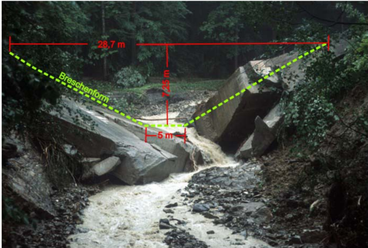
Abbildung 23: Foto mit skizzierter Breschengeometrie (Blick bachaufwärts)
