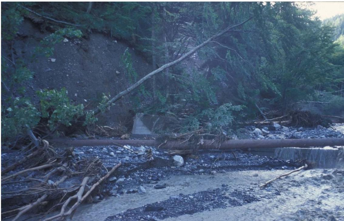
Abbildung 50: Vorderberger Bach hm 77,40: Konsolidierungssperre beiderseitig Flügeleinbindung zur Hälfte erodiert.
