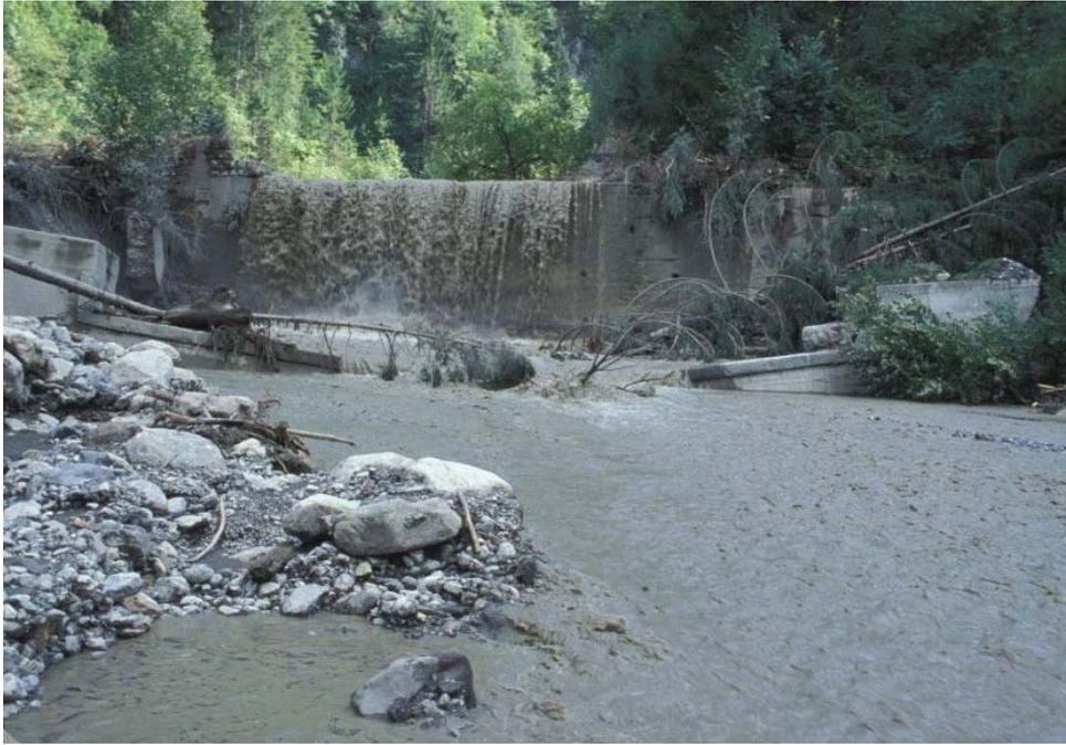
Abbildung 45: Vorderbergerbach hm 16,94: Seitliche Einbindung erodiert, anschließend Sperre gekippt.
