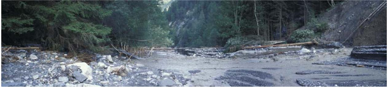
Abbildung 47: Vorderberger Bach hm 75,40: Konsolidierungssperre, rechte Flügeleinbindung erodiert.
