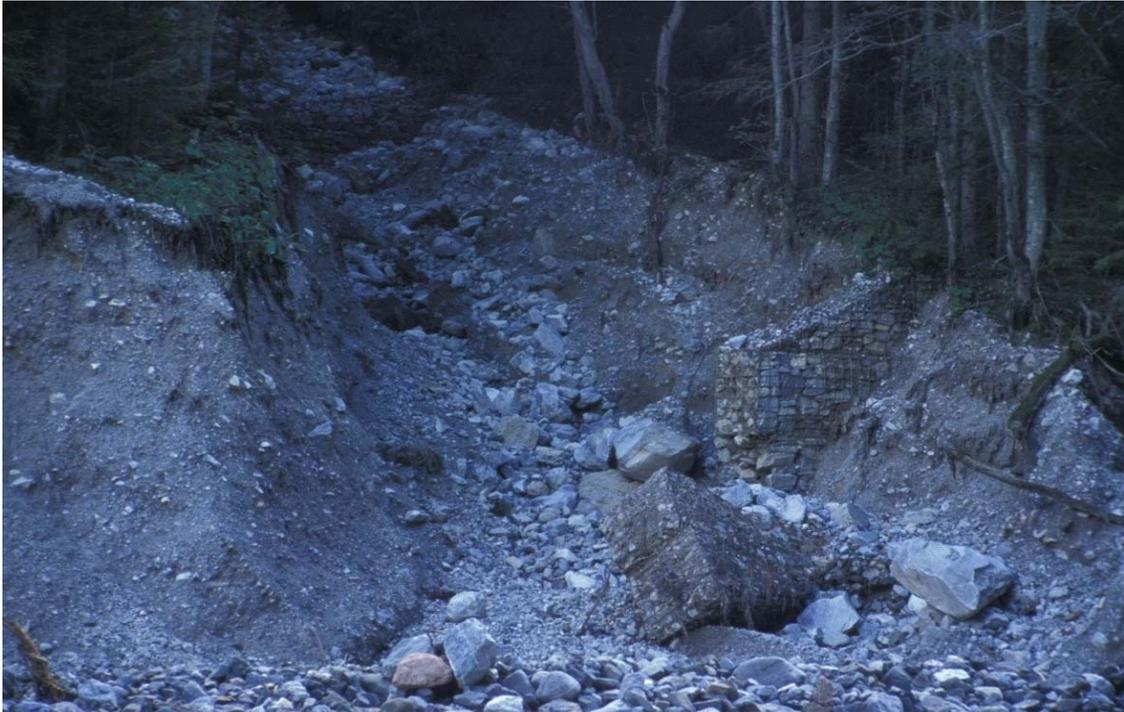
Abbildung 49: Vorderberger Bach hm :76,00 Seitlicher Drahtschotterkörper Einbindung komplett erodiert.
