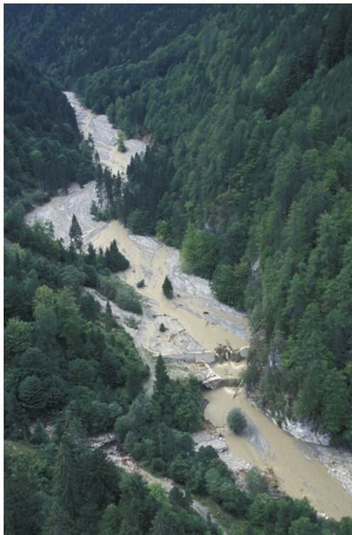
Abbildung 34: Murbrecher Vorderbergerbach hm 27,80; dahinter: abgelagertes Geschiebe nach dem Ereignis
