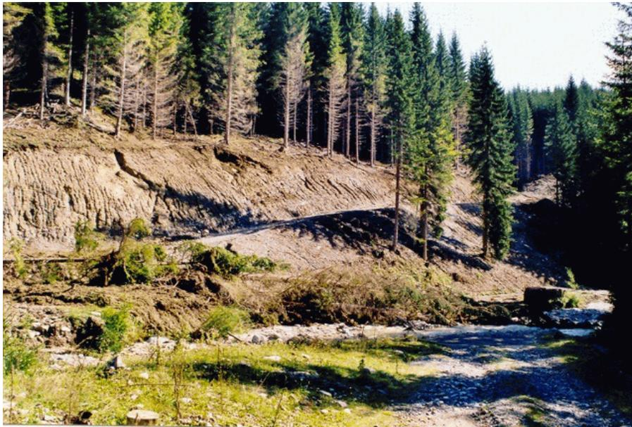
Abbildung 74: Durch ungünstige Trassenführung im Forststrassenbau verursachte oberflächliche Hangbewegungen und Erosion am Dolinzabach (Seebach) 950 m SSE der Dolinzaalm. Es werden feinkörnige quartäre Sedimente der Grundmoräne angeschnitten.
