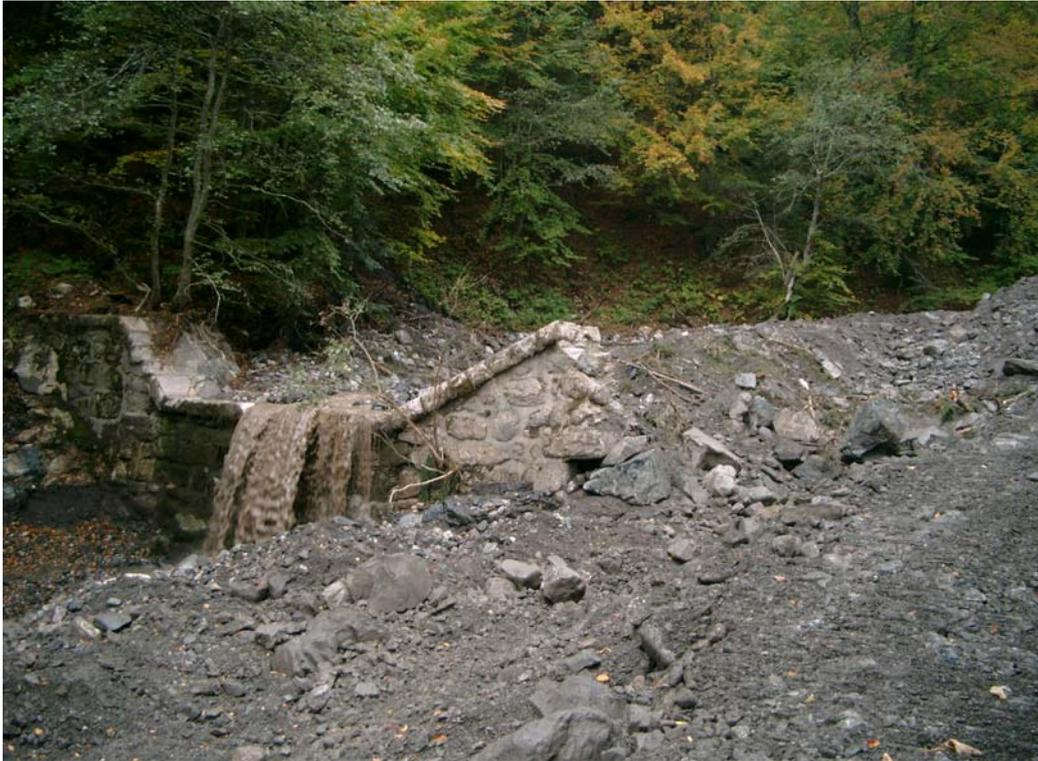
Abbildung 55: Feistritzbach hm 69,24: Linker Seitenflügel der ZM- Sperre gebrochen
