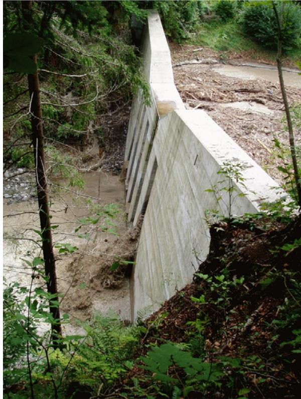
Abbildung 26: Dosierversperre Feistritzbach hm 21,65; bachaufwärts: Abgelagertes Geschiebe nach dem Ereignis (28.10.2003).
