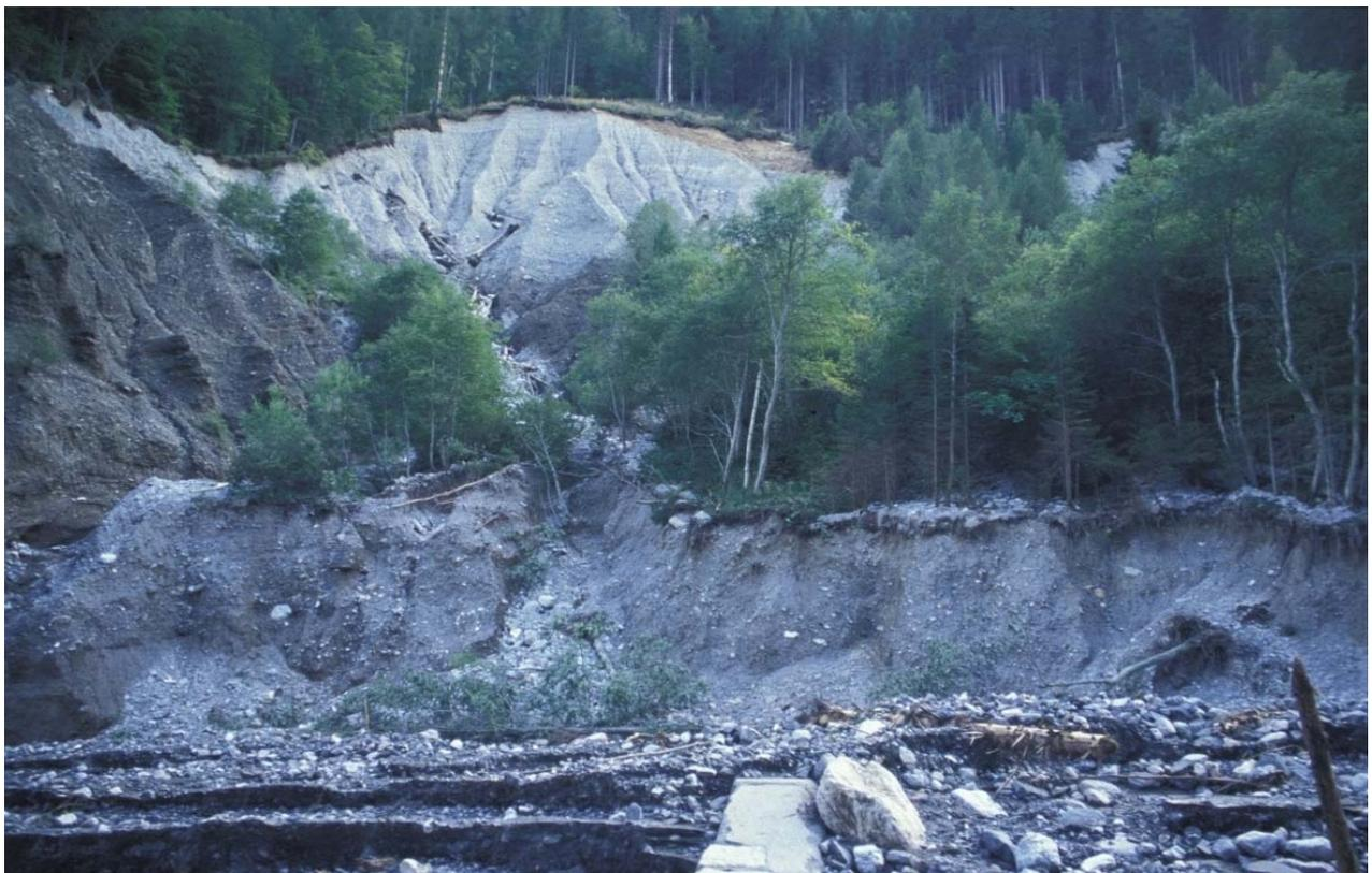
Abbildung 48: Vorderberger Bach hm 76,00: Konsolidierungssperre rechte Flügeleinbindung erodiert.
