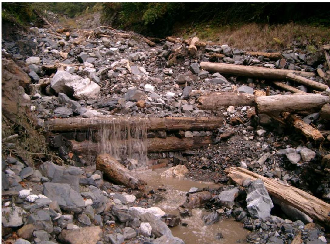
Abbildung 58: Quellbach hm 4,44: Schwer beschädigte Steinkastensperre
