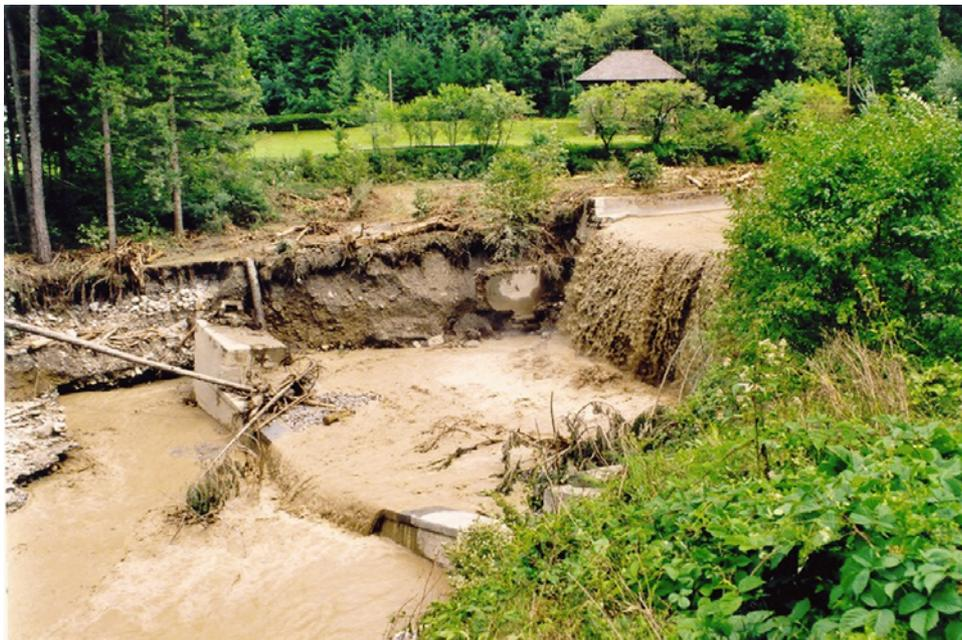
Abbildung 44: Vorderbergerbach hm 16,94: Seitliche Einbindung erodiert, anschließend Sperre gekippt.
