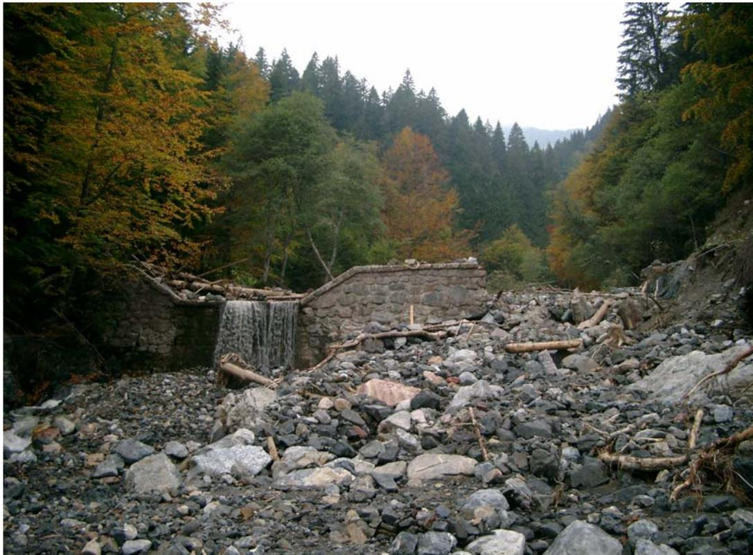
Abbildung 57: hm 79,85: Linker Seitenflügel der ZM- Sperre gebrochen
