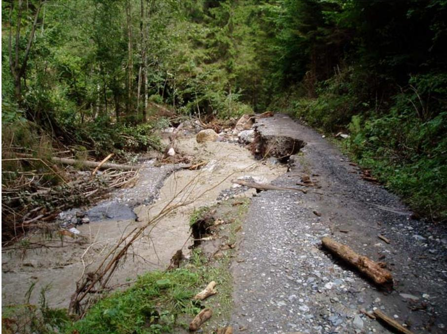
Abbildung 54: Forststrasse entlang des Feistritzbaches zerstört. Foto: WLV am 01.09.2003
