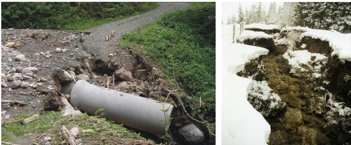
Abbildung 18: Durchlässe als potentielle Gefahrenstellen (links), Erosion eines Forstweges aufgrund verstopfter Durchlässe (rechts) (FOTO: Holub M., Hübl J.)
