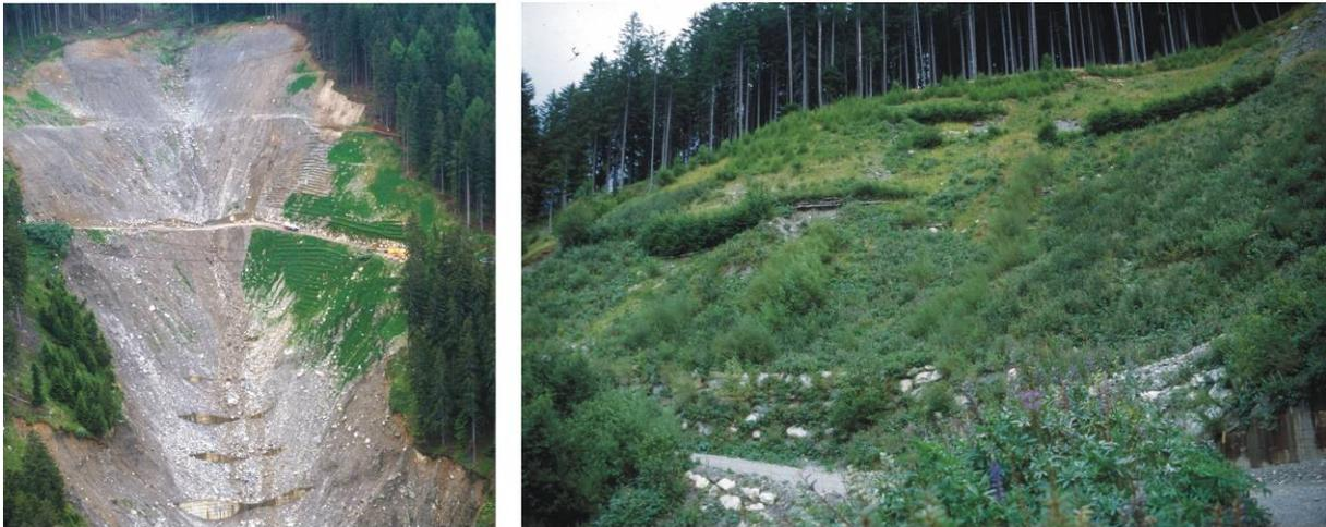
Abbildung 26: Stabilisierung der Prünsterlahn/SüdTirol mittels Holzkrainerwänden (FOTO: Florineth F.)
