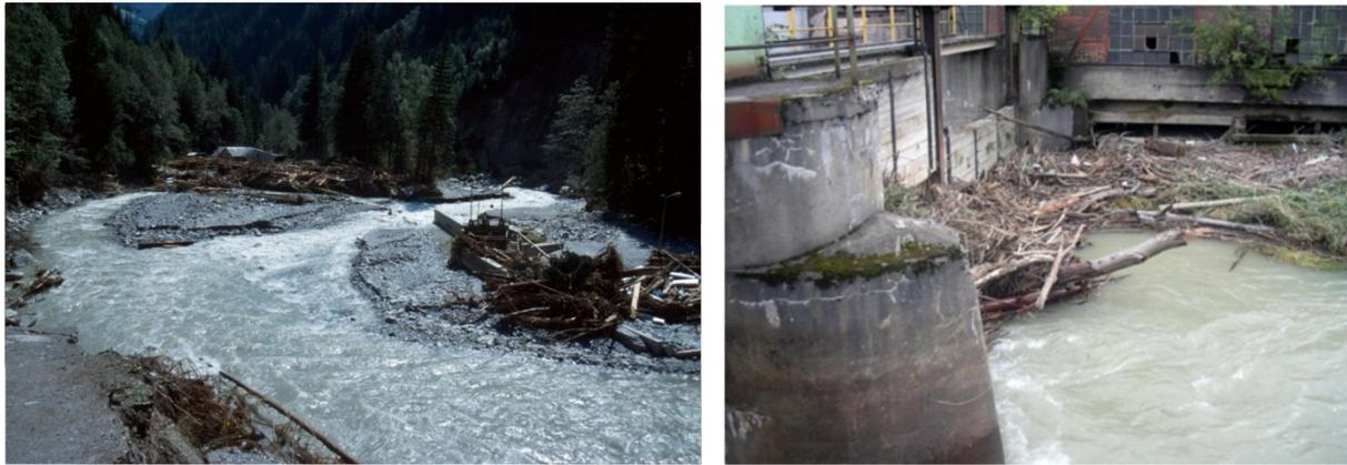
Abbildung 17: Verklauung an Wehranlagen, Rosanna bei Strengen Tir (links), und Thörlbach Stmk (rechts), (FOTO: Hübl J., FF Böhler)
