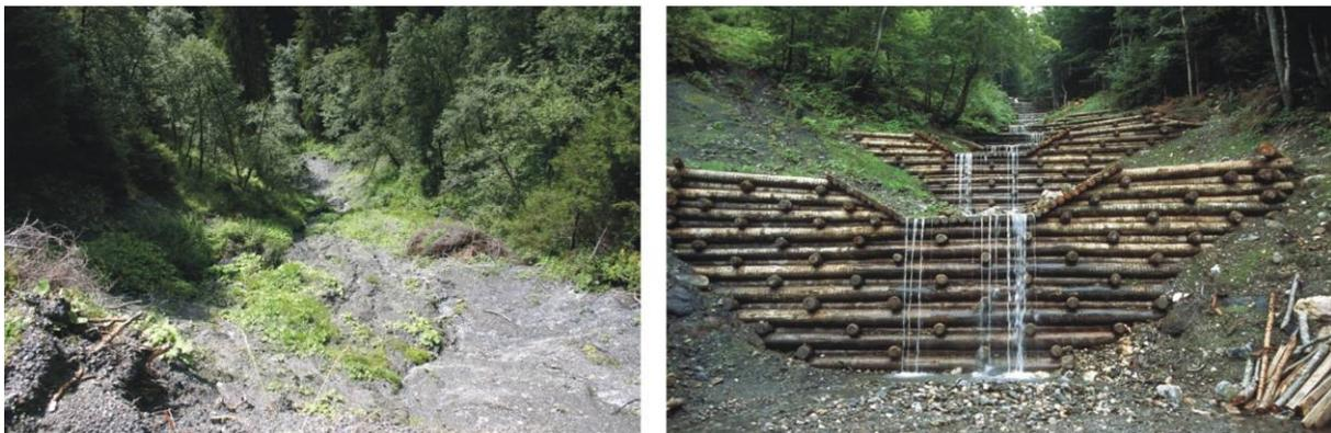
Abbildung 27: Sicherung von Runsen und Gräben (FOTO: Lammeranner W., Hübl J.)
