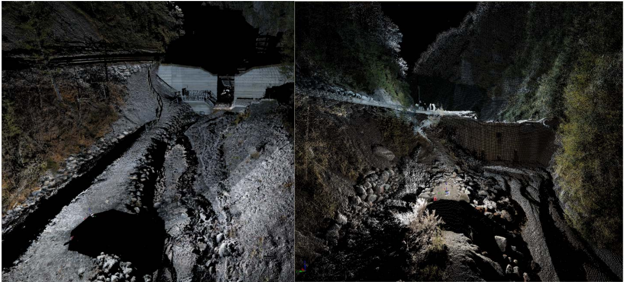
Abbildung 3. Punktwolken der neuen Sperre in der Laserscann-Aufnahme vom 16.11.2009 (links), im Vergleich dazu die alte Sperre 2008 (rechts).
