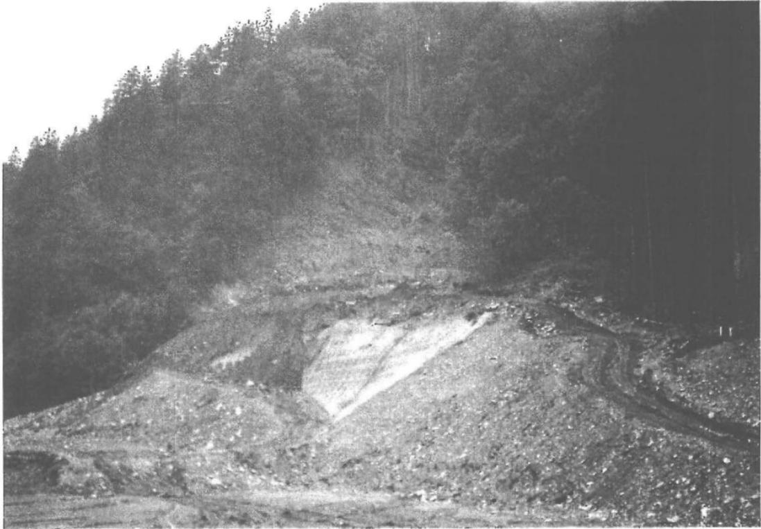
**Abb. 6:** Tunnel Wald, Voreinschnitt Ostportale: Abräumen der mächtigen, nachdrängenden Schuttansammlungen einer Felsrinne; darunter sichtbare temporäre Böschungssicherung ist bereits unstabil.
