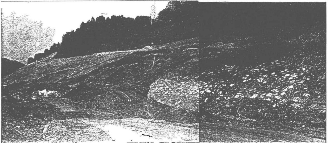
Abb. 10: Rutschung Wald - West, Blick gegen Nord: Anrisse bis zur Böschungsoberkante; Durchnässung, Vorwölbungen und Überschiebungen am Fuß der flächigen Steinschlichtung (Juli 1991).
