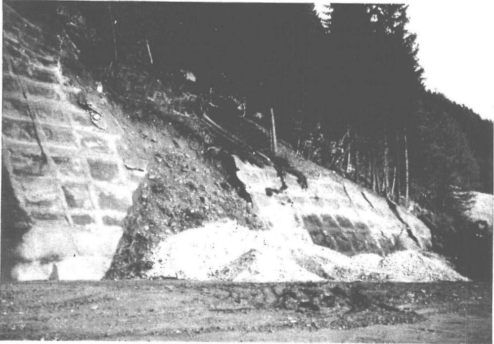
Abb. 7: Pretallerkogeltunnel, Bereich Ostportale; Geborstene und vorgeschobene Böschungssicherung nach dem Einsetzen von Massenbewegungen in der Lockermaterialfüllung steiler Felsrinnen.
