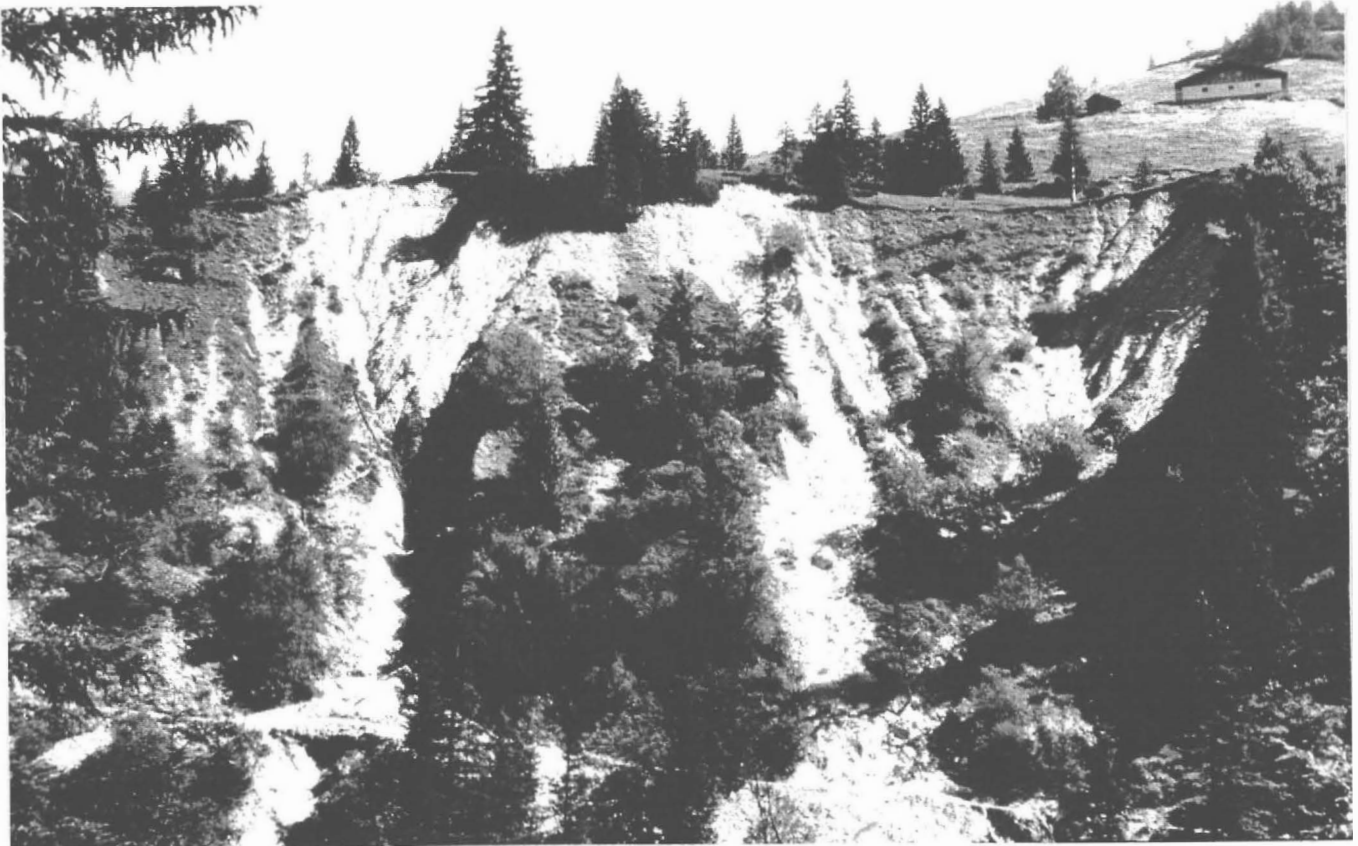
Abb. 2: Zusätzliche Wassereinträge aus oberen Hangbereichen führen oftmals in unterliegenden, gut wasseraufnahmefähigen Böschungen zu Rutschungen.
