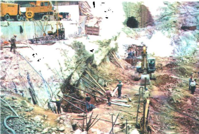
**Abb. 9** Ausräumen der 4 m mächtigen Plunge Pool Fault. Die Störung fällt mit 65° nach Norden. Der luftseitige Mauerfuß verläuft links vom Bagger. In der linken oberen Bildecke sind einige Betonblöcke für das Tosbecken erkennbar. Das Stollenmundloch am oberen Bildrand ist der Injektionsstollen RGG-0. Die Sohle des Aushub liegt 20 m unter der ehemaliger Talsohle. Blickrichtung nach Osten.
