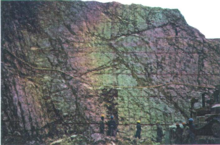
**Abb. 3** Schichtflächen parallele Scherzonen in Kalk, hervorgerufen durch **Biegegleitfallung**, versetzen SW-fallende Störungsbahnen in Richtung **Faltenscharnier** (= links oben) Linkes **Widerlager**, Aussichtsplattform **Strichpunktliert**, Scherzone, **strichliert** Störung
