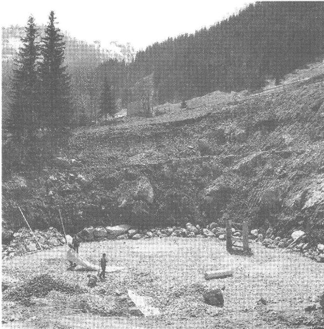
Die Künette für die Beileitung Hoarbergbach wurde nach Fertigstellung der Zufahrt zur Wasserfassung mittels einer Grabenfräse aufgedrückt. Überwiegend konnte in weichem und blättrigen, aber in der Künette standfestem Quarzphyllit gefräst werden; dadurch war die Abrasivität des Gesteins sehr gering. Durch eingelagerte dm-m mächtige Quarzadern und -linsen wurde allerdings auf < 1 % der etwa 1 km langen Grabenstrecke gleich viel Werkzeugverschleiß festgestellt wie im übrigen Teil.
