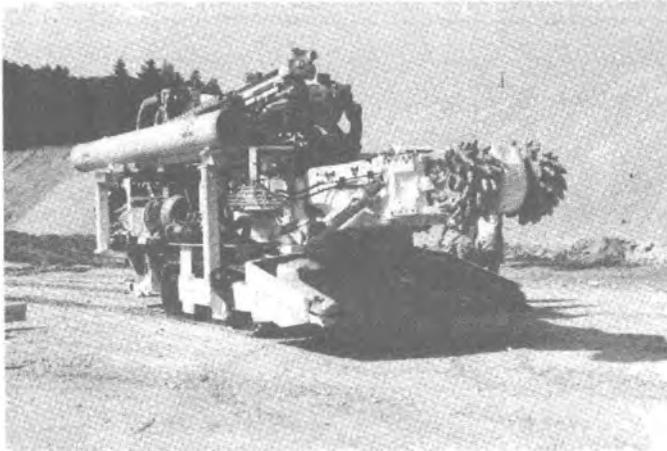
Abb. 8: Anlieferung der Teilschnittmaschine
