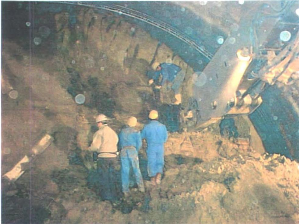
**Abbildung 1-8:** Kalottenvortrieb im Wachbergtunnel
