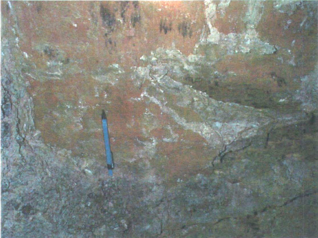
*Abbildung 7: Harnischfläche mit Strimung und oxidierten Kluftflächenbelägen im Kienberg-Fluchtstollen*
