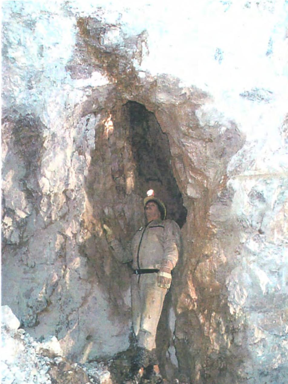
*Abbildung 5: Aufgeweitete Karstkluft im Wettersteindolomit (Fluchtstollen Spring Süd)*
