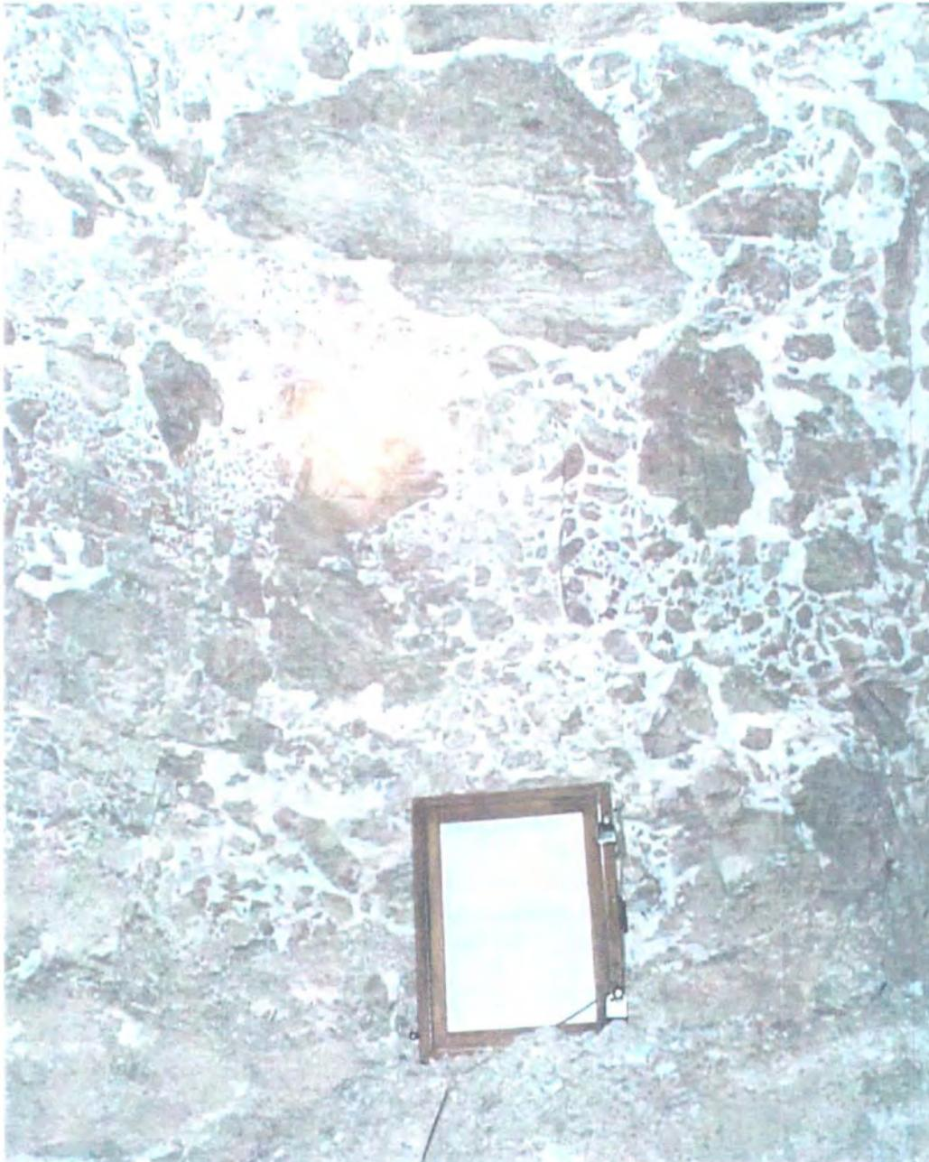
*Abbildung 3: Wettersteindolomitbrekzie mit weißem, dolomitischem Bindemittel (Fluchtstollen Spering Süd)*
