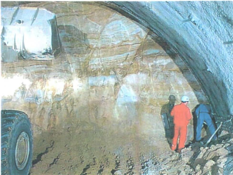
**Abbildung 1-4:** Melker Sand im Wachberg Tunnel (Kalotte)
