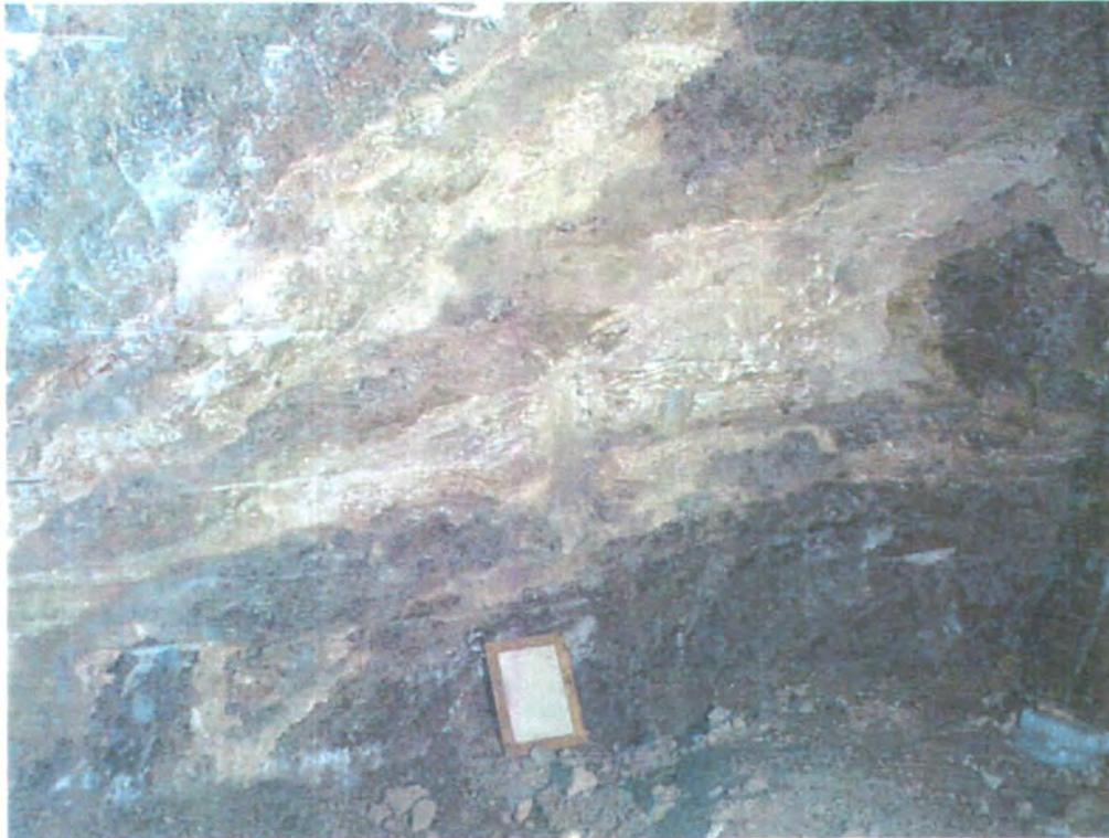
*Abbildung 6: Tektonische Zertrümmerung des Hauptdolomites im Kienberg-Fluchtstollen*
