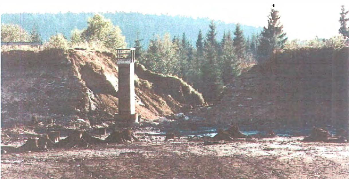
Abb. 11: Der wenige Tage nach seinem Einstau zerstörte Schlesinger Damm
