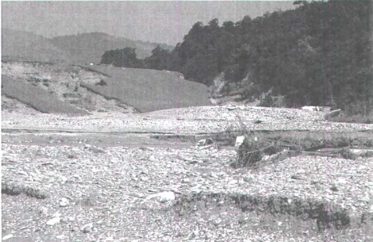
Abb. 9: Die linke Flanke des Belci Dammes nach der Überströmung
