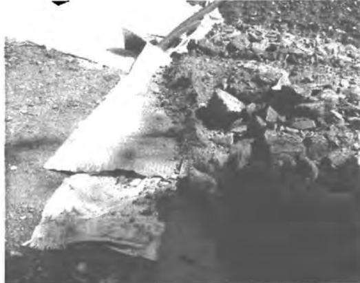
Abb. 12: Vlies, Geotextil, Ableitungsrohre
