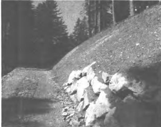
Abb. 11: Trasse mit Wurfsteinmauer
