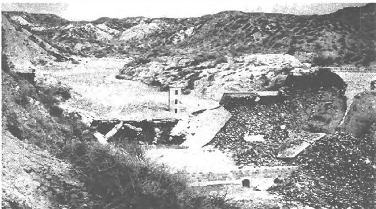
Abb. 8: Der binnen Minuten zerstörte Seco Frias Damm in Argentinien
