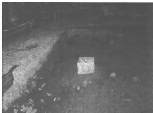
Abb. 15: Aufgefüllte Baugrube mit Piezometer
