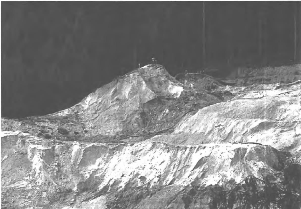
Abb. 12: Bruchquerschnitt des Abraumdammes von Stava
