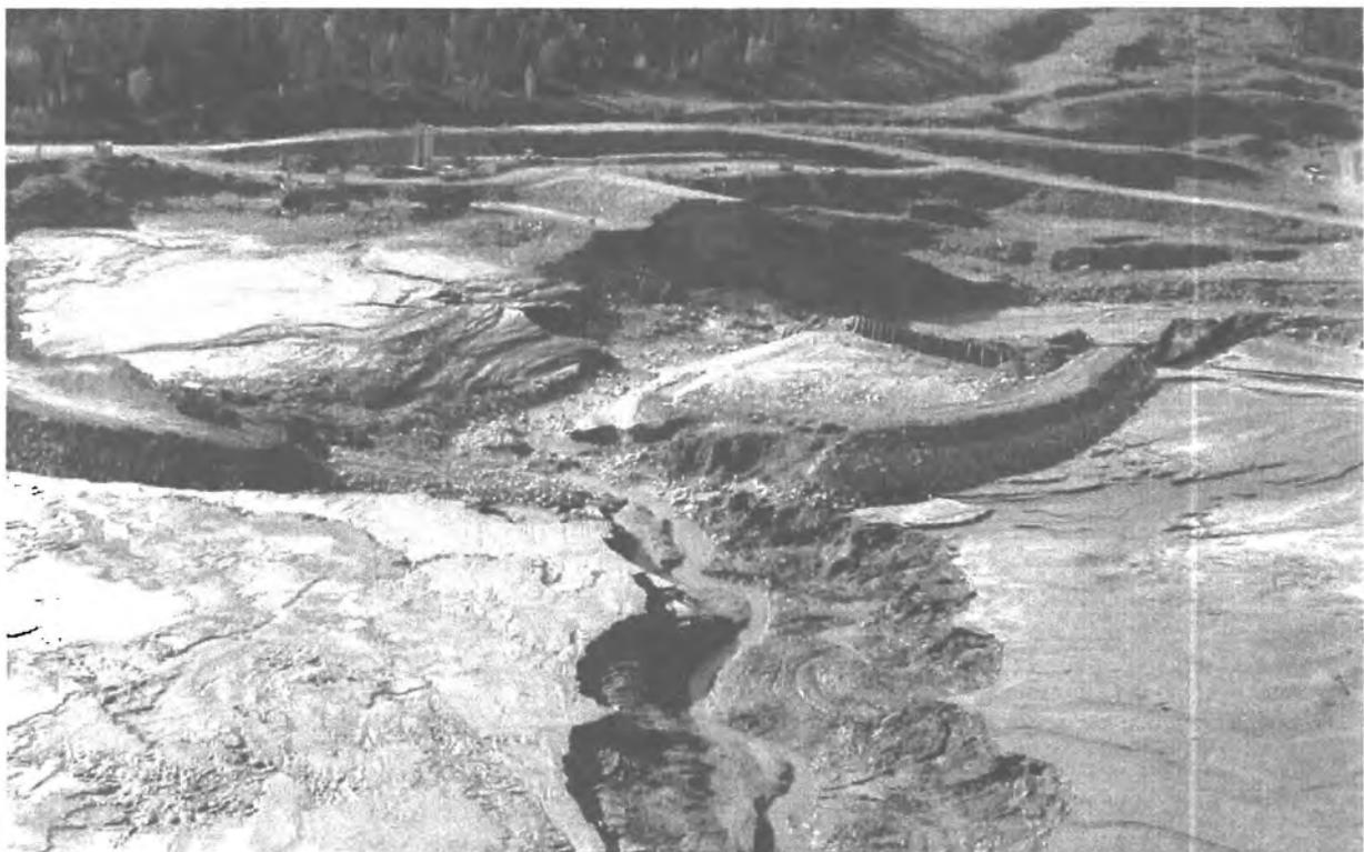
**Abb. 15: Der infolge innerer Erosion zerstörte Aitik Damm in Schweden**
