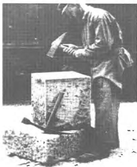
Abb. 26: Bearbeitung der Steinoberfläche mit der Bossierhacke (um 1930).
