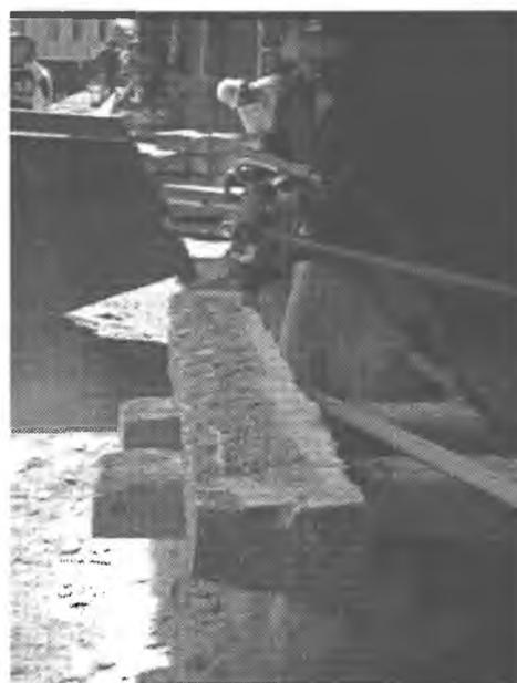
Abb. 27: Stocken mit dem Preßlufthammer.
