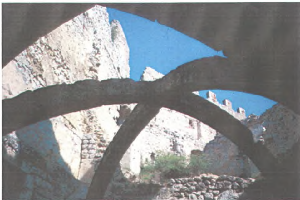
Abb. 9: Gotische Gewölberippen in der so genannten Schatzkammer der Burgruine Starhemberg aus Wöllersdorfer Leithakalk.
