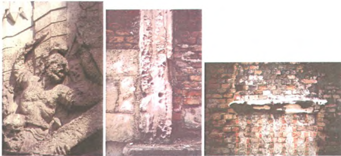
Abb. 6: Links: Kreuzwegstation von Stift Zwettl aus Zogelsdorfer Kalksandstein mit charakteristisch „pockennarbiger“ Oberfläche, hervorgerufen durch Salzsprennung.
