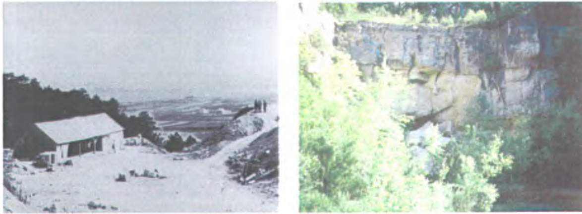
Abb. 31: Links: Blick aus dem Steinbruch im Rauchstallbrunngraben auf Baden um 1890 (Bildarchiv Inst. f. Ingenieurgeologie, TU - Wien). Rechts: Oberer Steinbruch im Rauchstallbrunngraben 1997.
