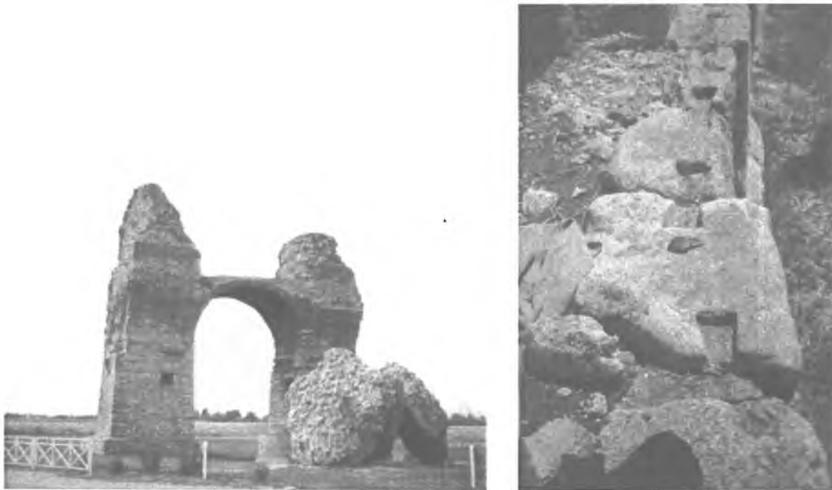
Abb. 1: Links: Das Heidentor von Carnuntum - ein Beispiel für die Verwendung von „opus caementitium“ („Römischer Beton“). Die Steinverkleidung und Gesimse stammen aus den Steinbrüchen zwischen Bad Deutsch Altenburg und Hundsheim. Rechts: Reste der Quaderverkleidung mit den charakteristischen „Schwalbenschwanzdübeln“ aus diversen Leithakalksandsteinen im Militäramphitheater zwischen Petronell und Bad Deutsch Altenburg.
