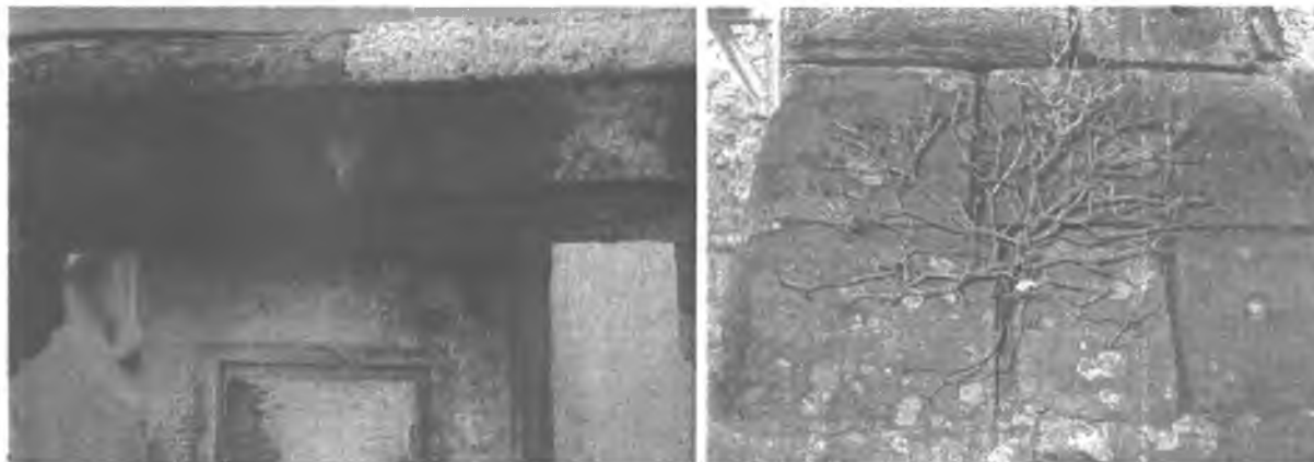
Abb. 8: Links: Balustrade (Mariensäule Wiener Neustadt, Hauptplatz) mit biogenem Bewuchs (Moose, Algen, etc.) an der Unterseite als Hinweis für gutes Wasserrückhaltevermögen im Stein.
