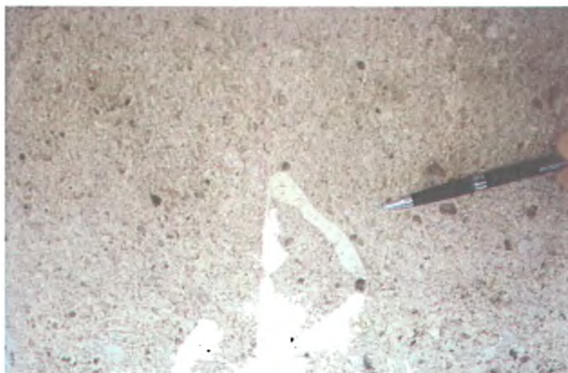
Abb. 27: Feinkörniges Bad Fischauer Konglomerat mit Seeigelquerschnitt ( Clypeaster sp.) in der Bausubstanz des Wiener Neustädter Domes.
