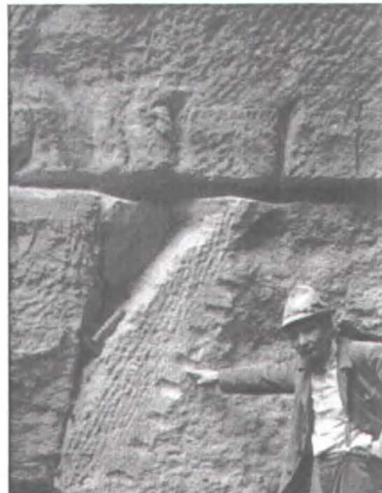
Abb. 24: Links: Aufgelassener Steinbruch bei Winden am Neusiedlersee (1993). Derzeit wird der Steinbruch als Bauschuttdeponie von der Gemeinde Winden genutzt. Rechts: Steinmetzmeister Friedrich OPFERKUH (Mannersdorf/Lg.) weist auf Schrämm Spuren und Keiltaschen im links dargestellten Steinbruch hin.
