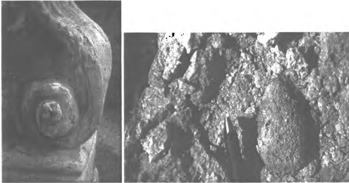
Abb. 7: Links: Barocke Volute (Gloggnitz/NÖ) aus Kalksandstein von Au am Leithagebirge mit Zementmörtelinkrustierungen durch Frostsprengung zerstört.
