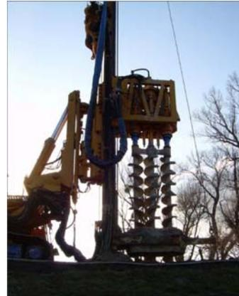
**Abb 2. Mixed in Place Gerät am Damm**
