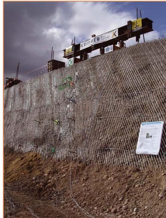
Maßgebend war nachzuweisen, dass selbst im Falle eines Böschungsbruchs bei sinnvoller Vernagelung nur geringe Belastungen in dem Oberflächensystem auftreten.
