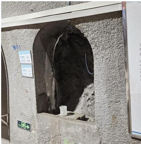
Abbildung 34: Eins der Fenster im Tunnel, um den Boden erkunden zu können
