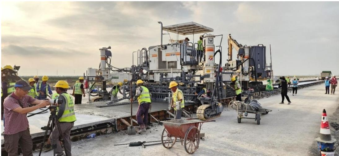
Abbildung 56: Herstellung der Landebahn mittels Gleitschalungsfertiger
