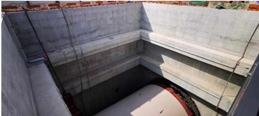
Abbildung 54: Baugrube mit TBM
